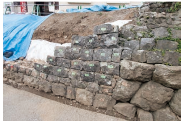
石垣南端部の積み直し
