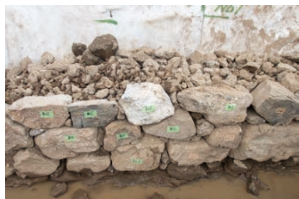
崩壊箇所の積み直し
