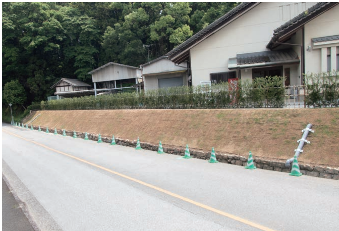
高知公園西ノ丸西側石垣改修工事竣工(南西より)
