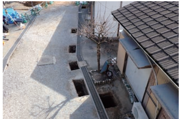
C区トレンチ掘削状態(北より)
