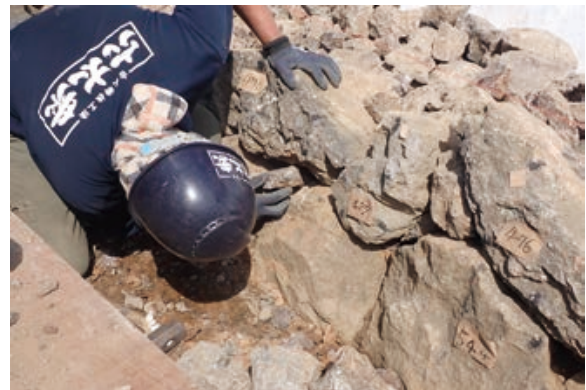
築石間に間詰め石を充填する
