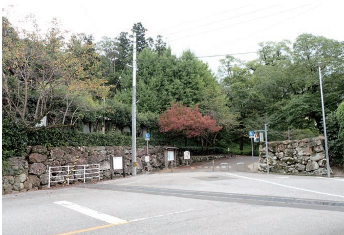
搦手門石垣(北西より)
