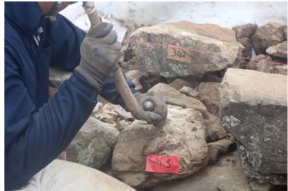
築石据わり部分の加工（新補石）
