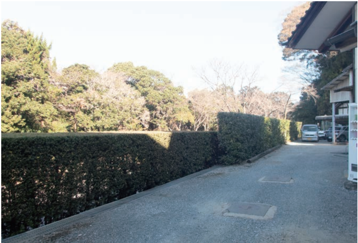
高知公園西ノ丸改修工事前風景（南東より）
