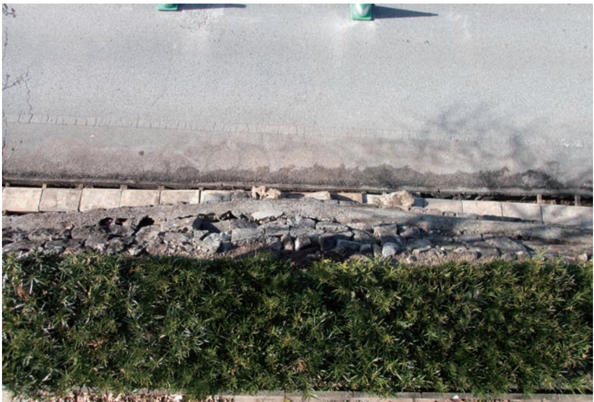
西ノ丸平場から見た崩落箇所の状態（上空より）
