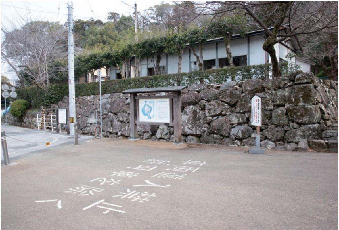
搦手門東側石垣西面(南西より)
