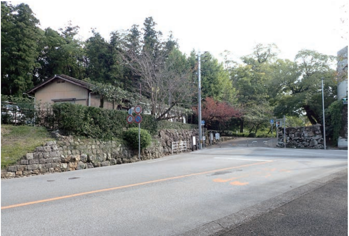
搦手門石垣と西ノ丸西側石垣（北西より）
