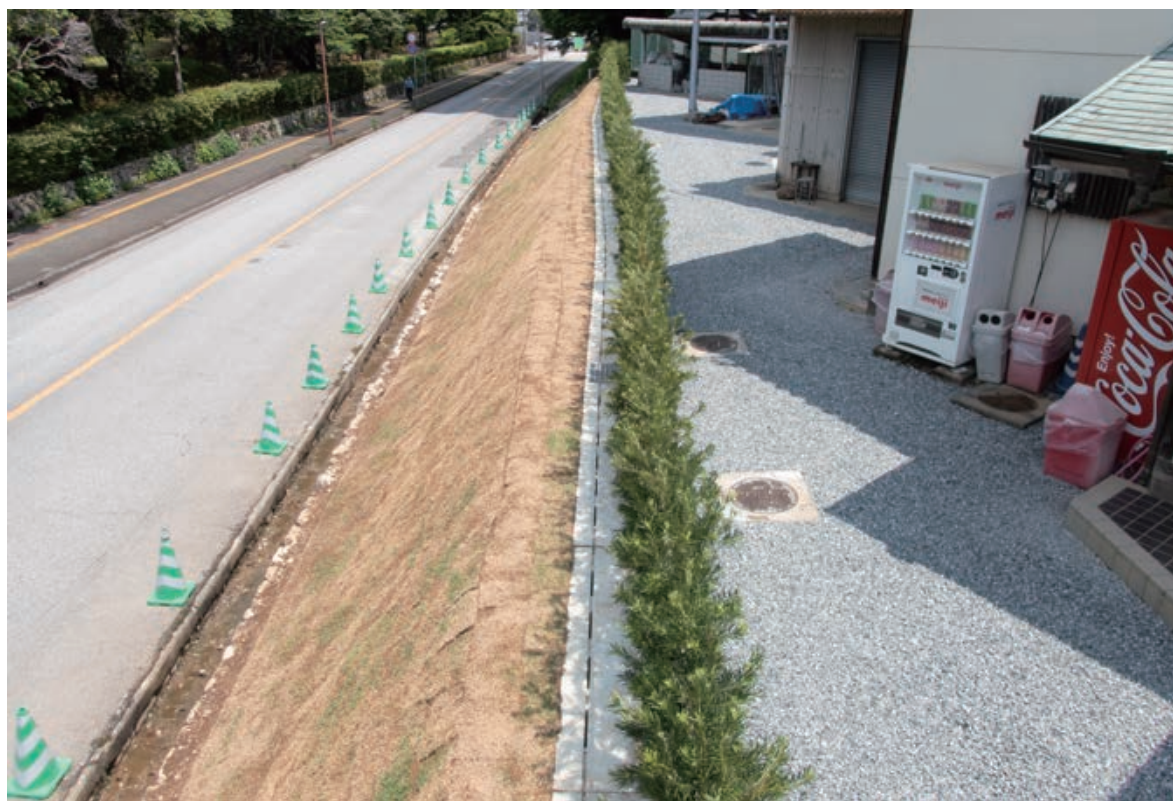
高知公園西ノ丸西側石垣改修工事竣工(A・B区)(南より)
