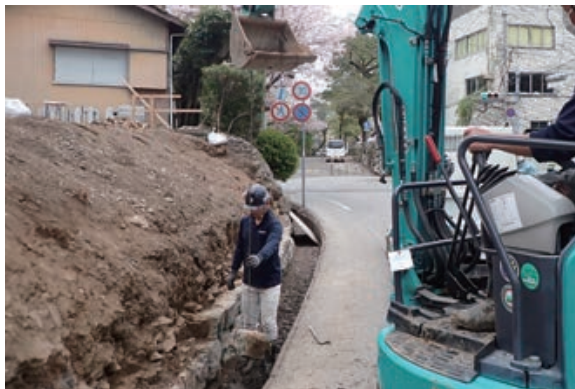
B区築石の取り外し
