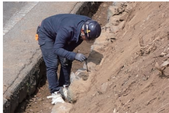
B区解体築石への番号付け
