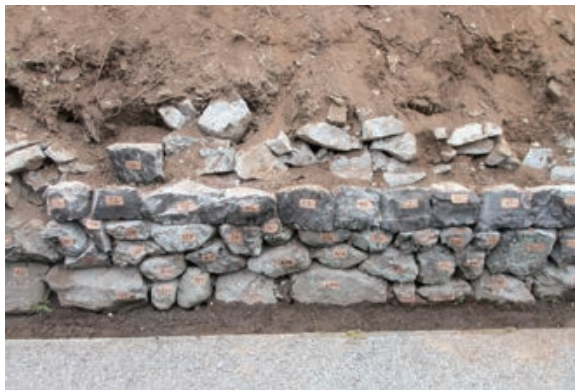
B区コンクリート壁撤去後の石垣
