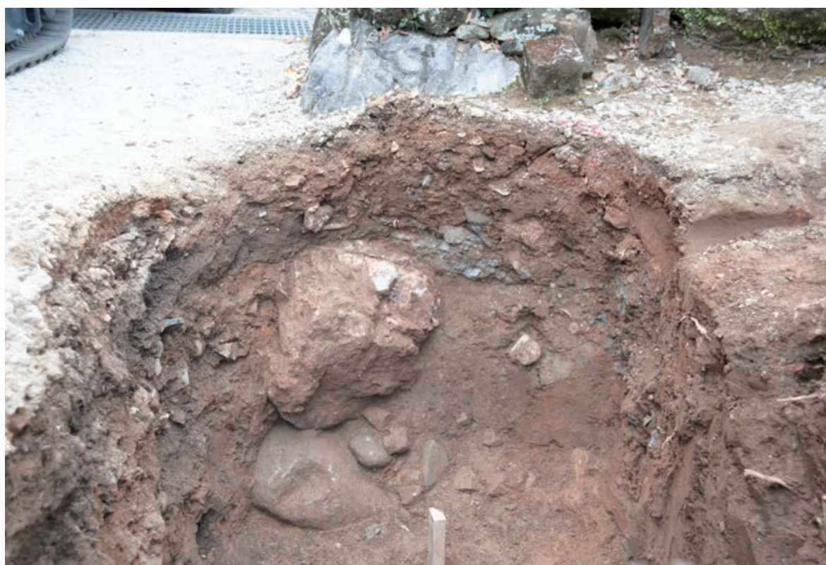
D区搦手門東側石垣隅角部下築石検出状態2(北より)
