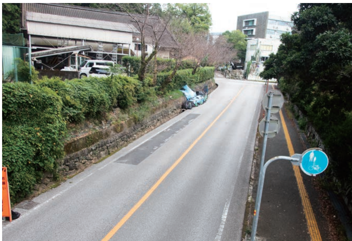
高知公園西ノ丸西側石垣改修工事前風景（北西より）
