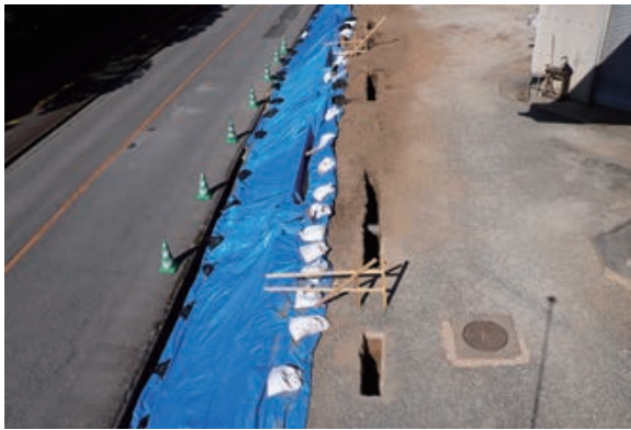
A区トレンチ掘削状態(南より)
