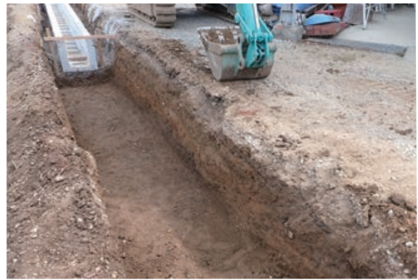
A区水路設置範囲掘削状態(南西より)
