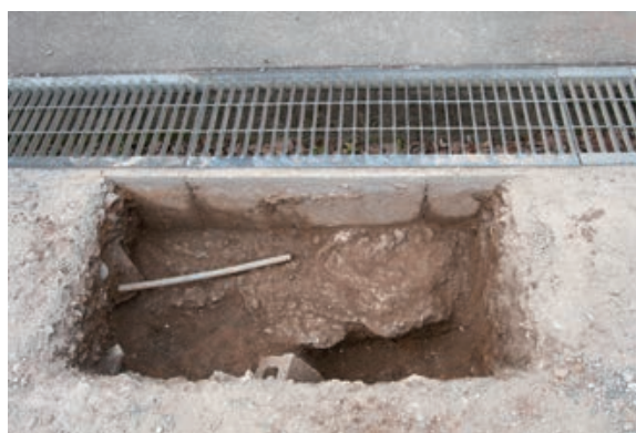
C区トレンチ7掘削状態(東より)
