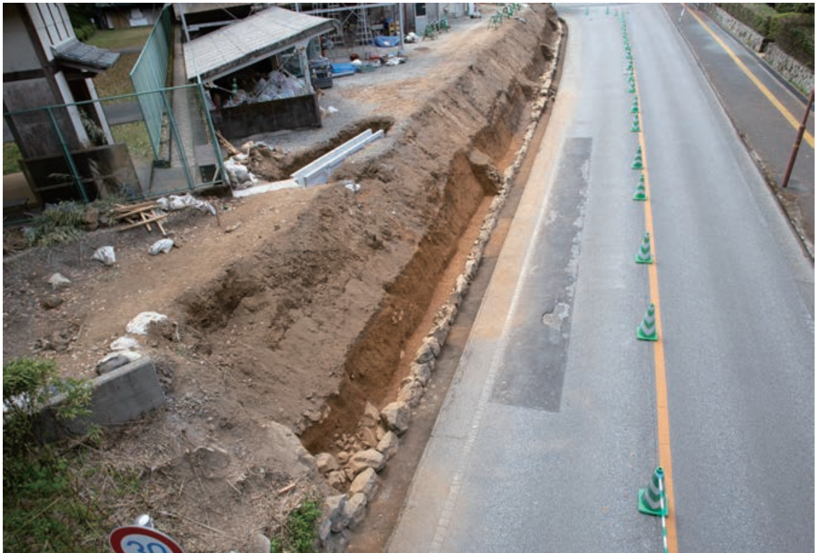
B区石垣解体最終面検出状態1(北より)
