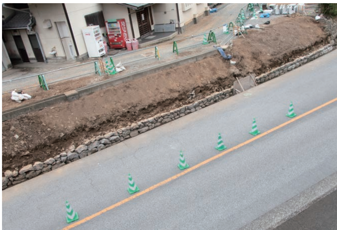
B区コンクリート壁下2段目解体石垣検出状態2(北西上空より)
