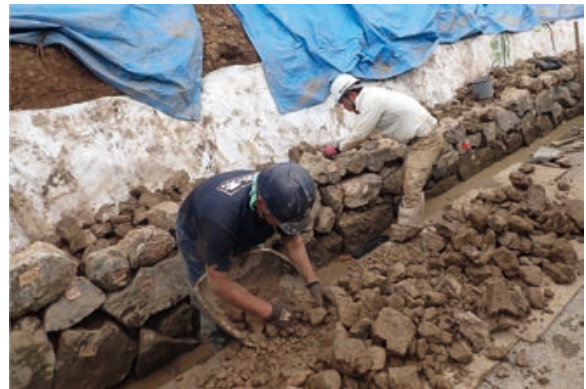
裏込め石の充填作業
