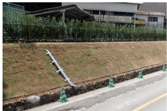
排水管の設置（北西より）
