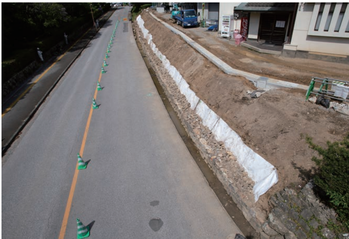
石垣積み直し状態(南西より)
