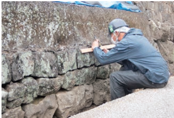
B区石垣墨付け作業
