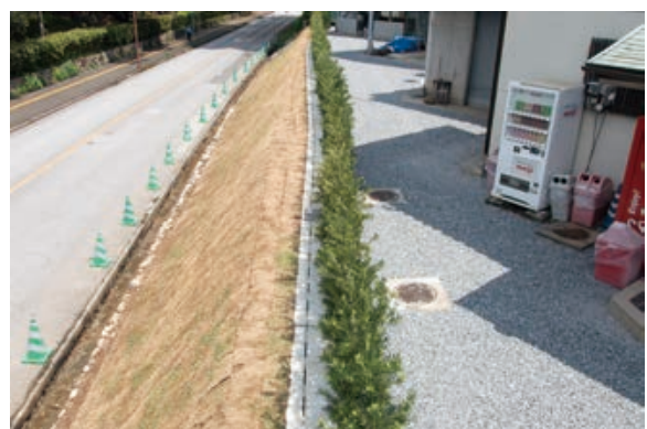
西ノ丸曲輪新設水路と植栽（南より）
