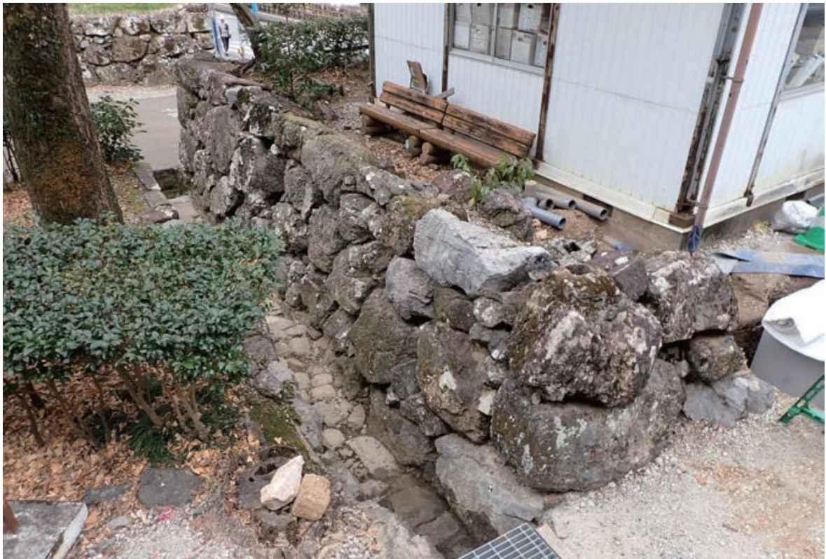
搦手門東側石垣南面隅角部(南東より)
