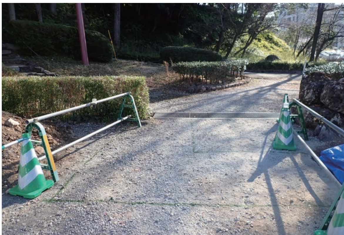
D区調査前風景(北より)
