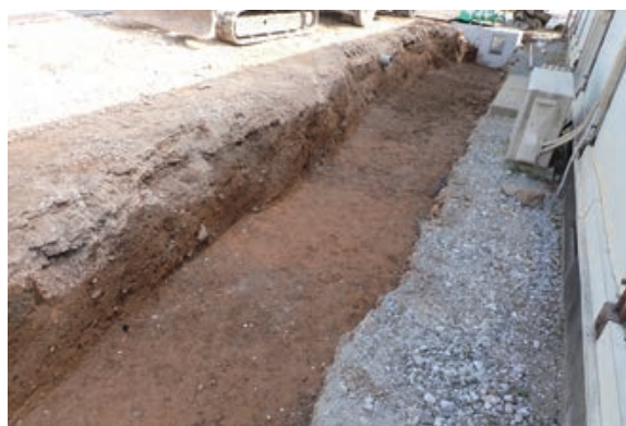
C区水路設置範囲掘削状態2(北西より)
