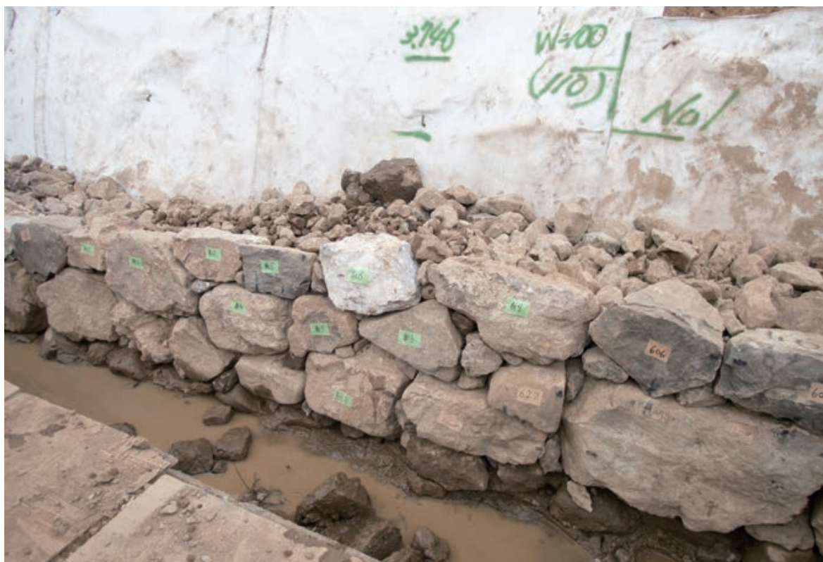
石垣崩壊箇所積み直し状態(南西より)
