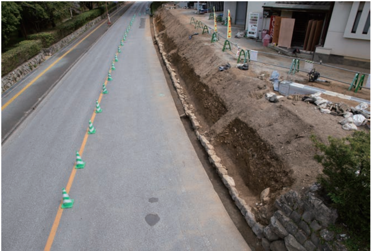
B区石垣解体最終面検出状態2(南より)
