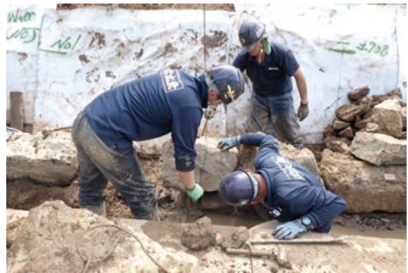
根石の据え直し
