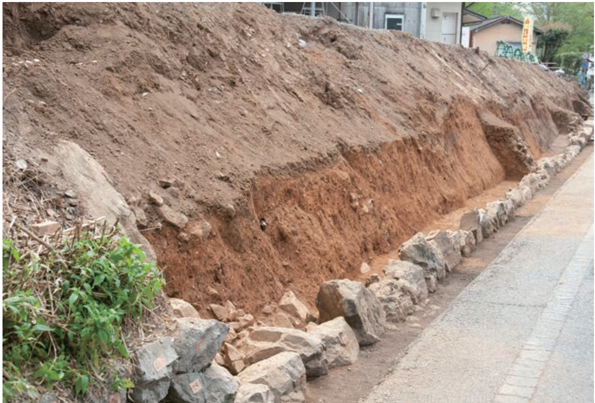
B区背面盛土セクション1(北西より)
