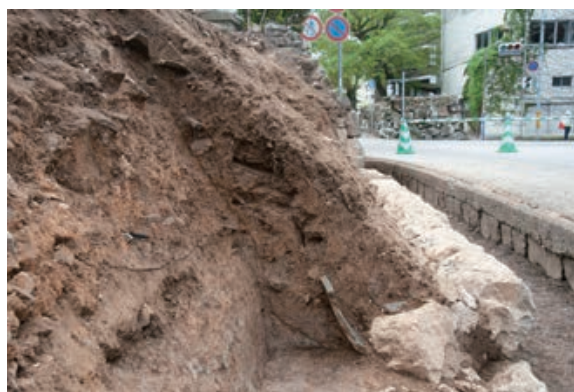
B区バンク4セクション(北より)
