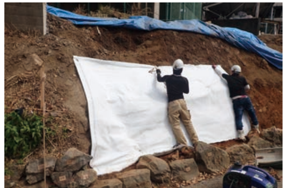
吸い出し防止シートの設置
