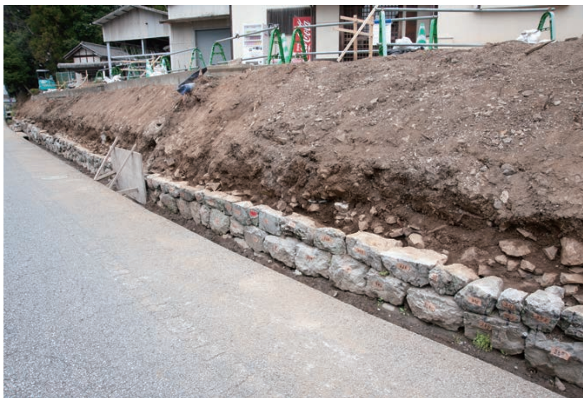
B区コンクリート壁下2段目解体石垣検出状態1(南西より)
