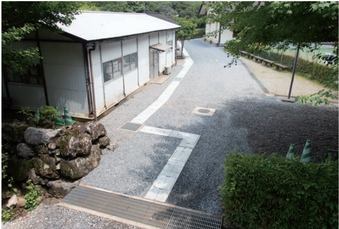
高知公園西ノ丸西側石垣改修工事竣工（C・D区）（南東より）
