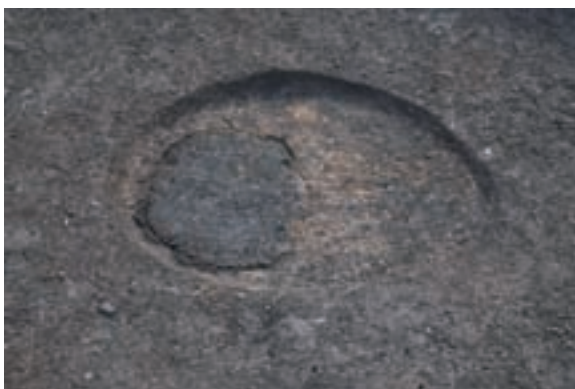
P19柱痕跡検出状況
