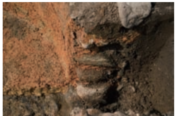
SK40 断ち割り状況
