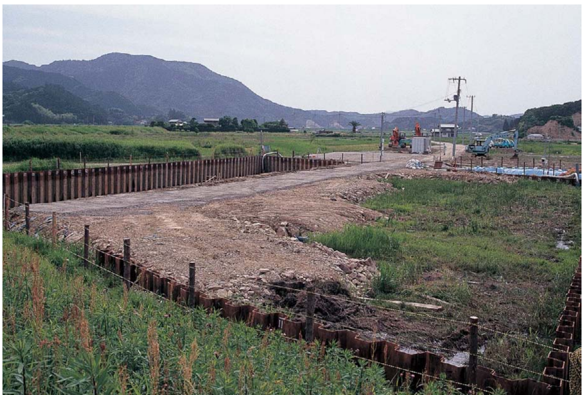
調査前全景2(東より)
