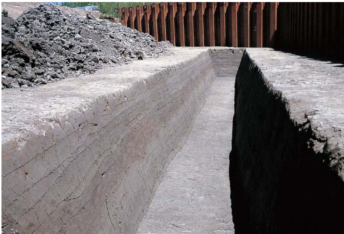
I区下層確認トレンチ(西より)
