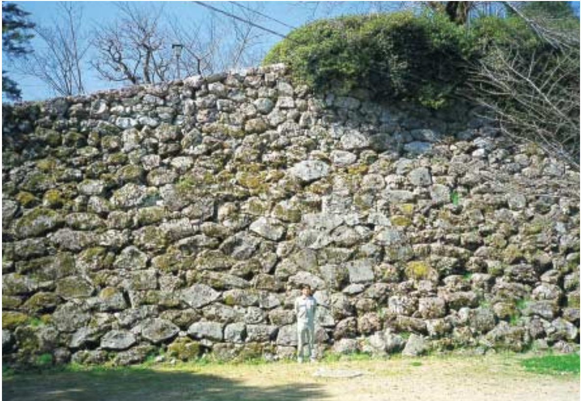
二ノ丸東石垣で人から右がチャートで占める石垣部分、左部分が砂岩が多く改修された石垣部分
