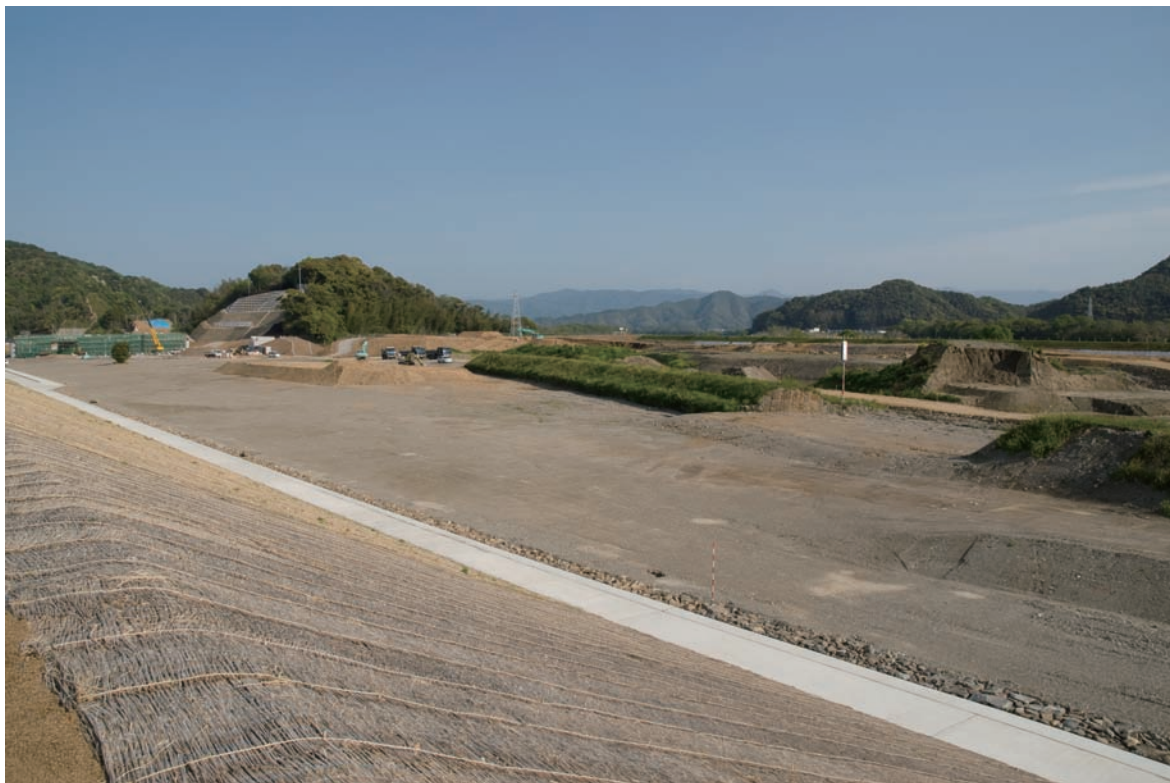
2 - 3区調査前遠景 (写真中央堤防下)
