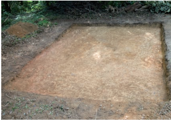
トレンチ1-1完掘（東より）
