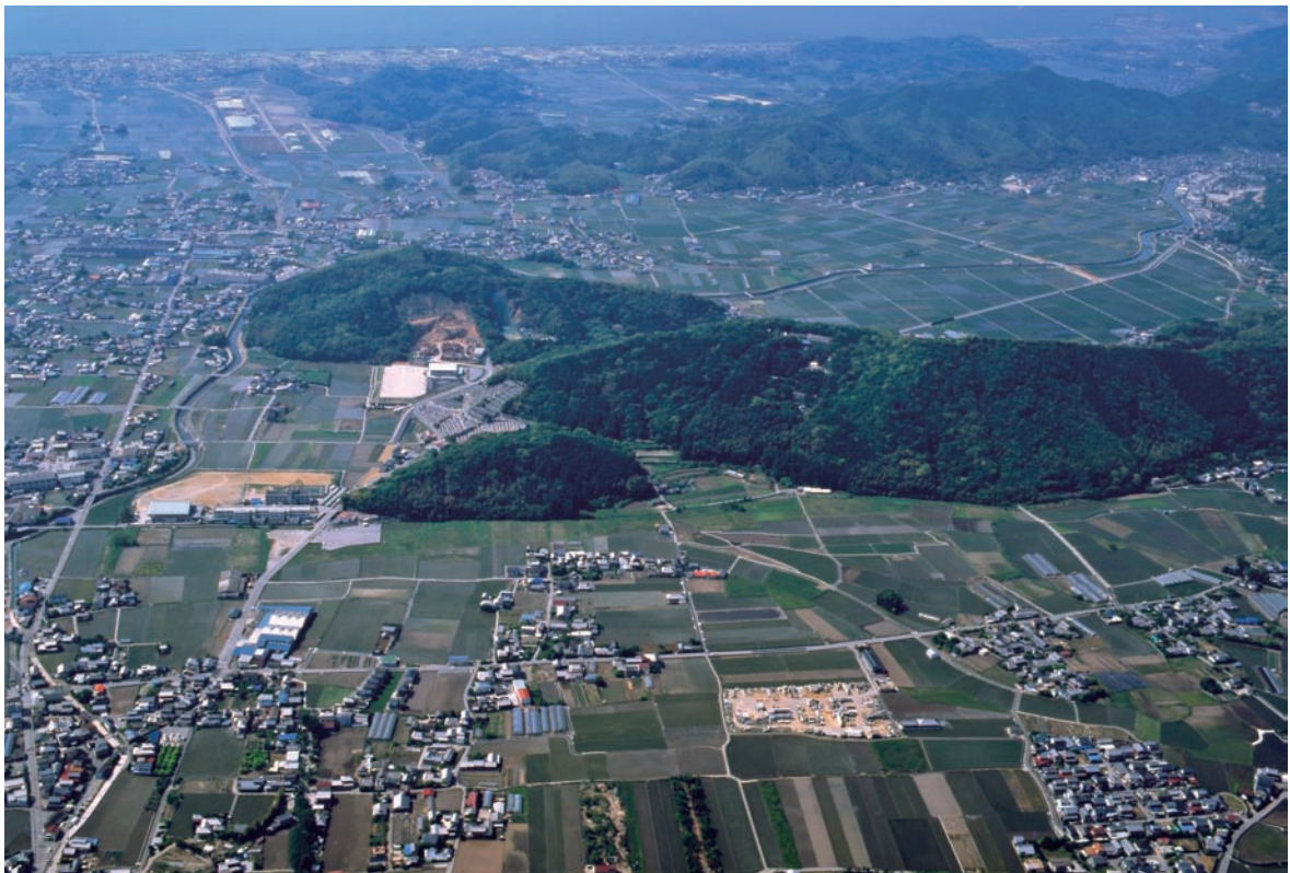
調査前全景 (北上空より)
