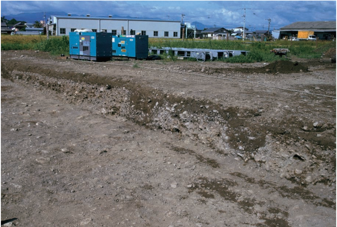
SB - 107, SD - 116 (西より)
