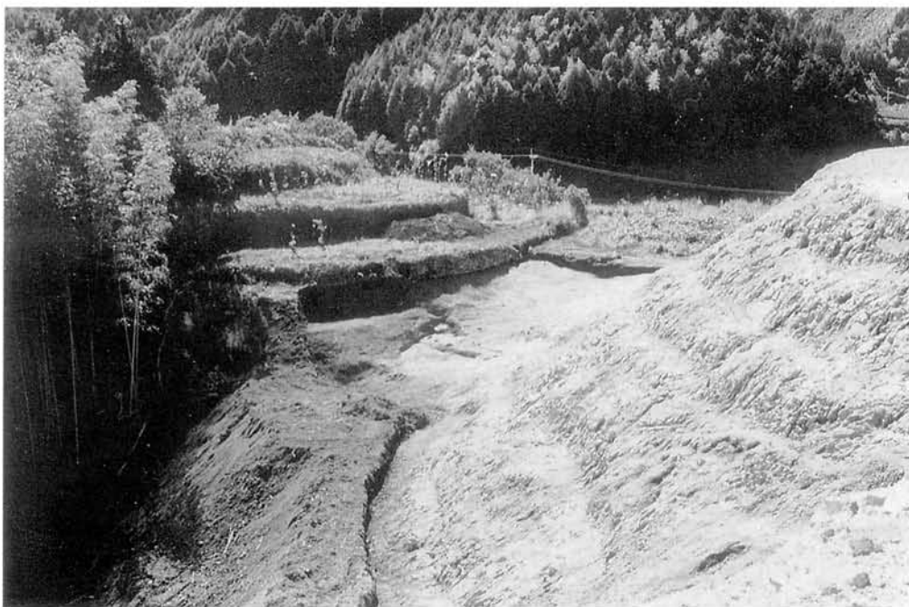
曲輪 3 東側斜面完掘状況
