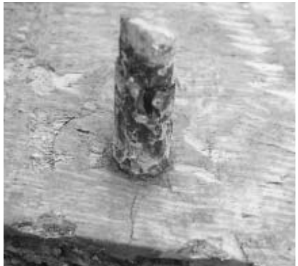
2-5区杭貫通状況
