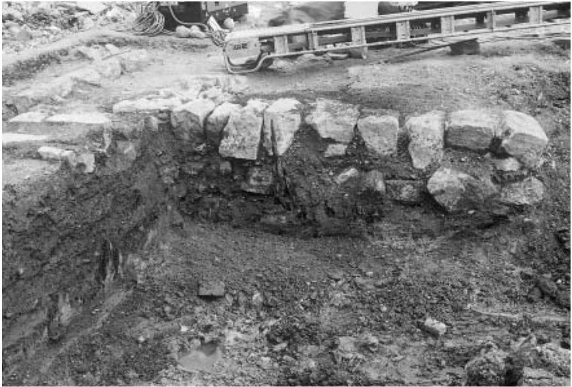
基礎遺構1側面(2~3-1区・北より)
