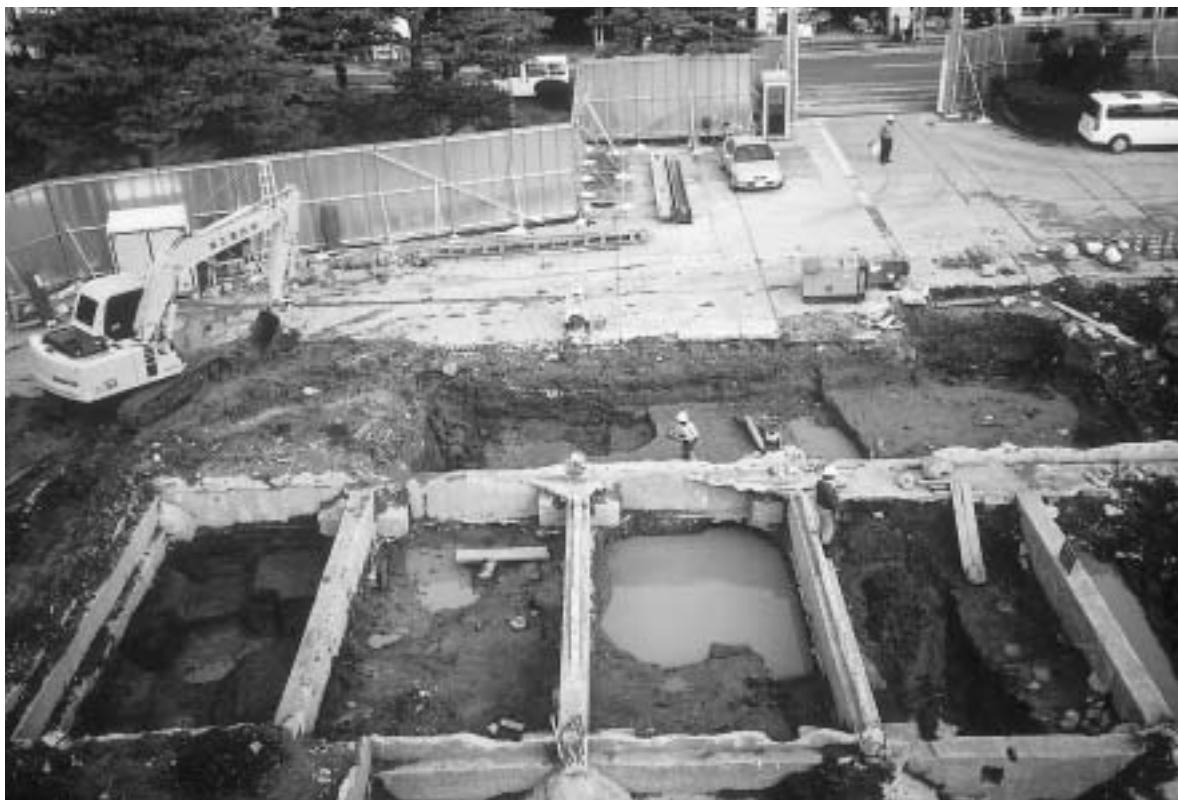
調査区南部完掘状況（北より）
