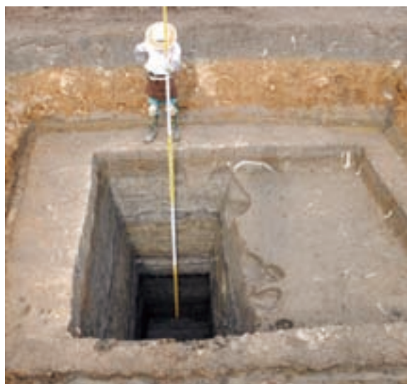
試掘トレンチ4
