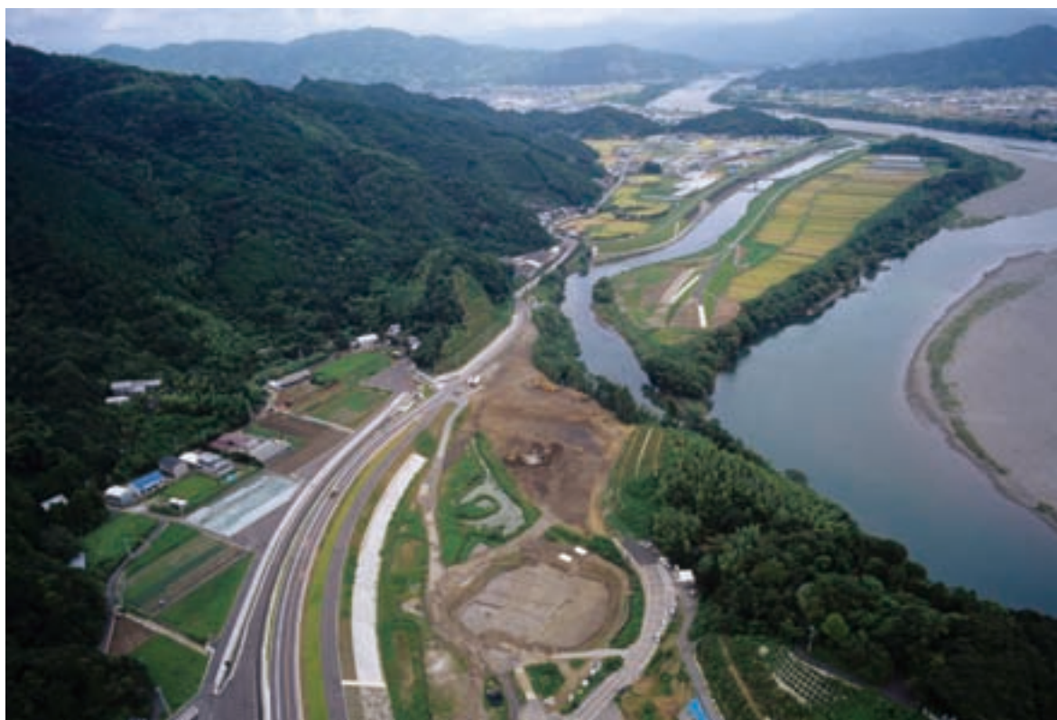
第5地点調査区遠景（南西より）
