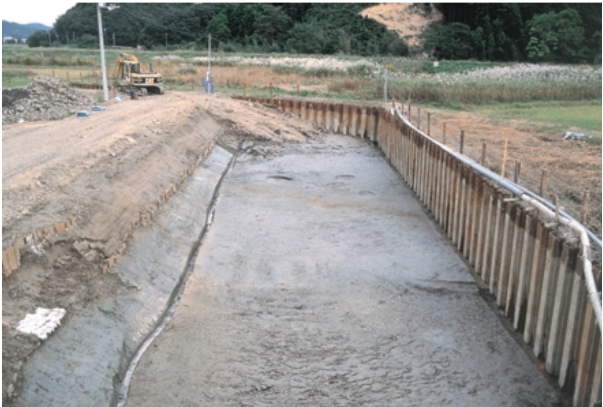
中世遺構完掘状態(西より)
