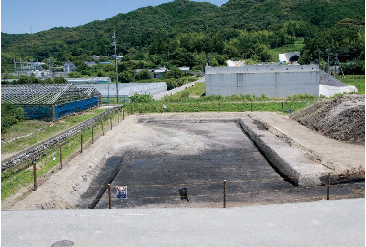
完掘状態(西より)
