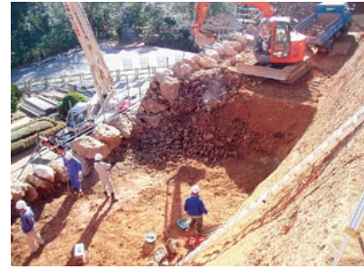
解体調査風景
