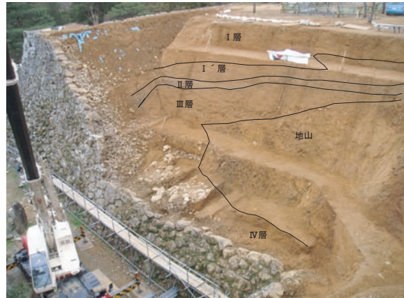
解体調査区南側部分の盛土層序写真
