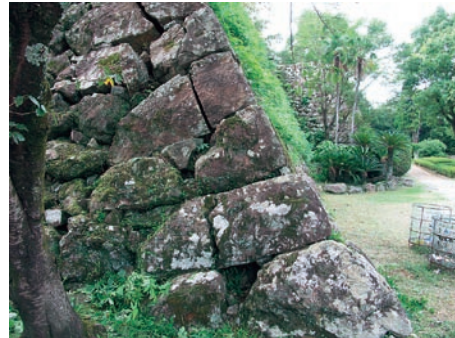
三ノ丸隅角部の石垣亀裂
