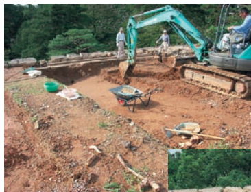
解体前の発掘調査でのコンボによる表土掘削
