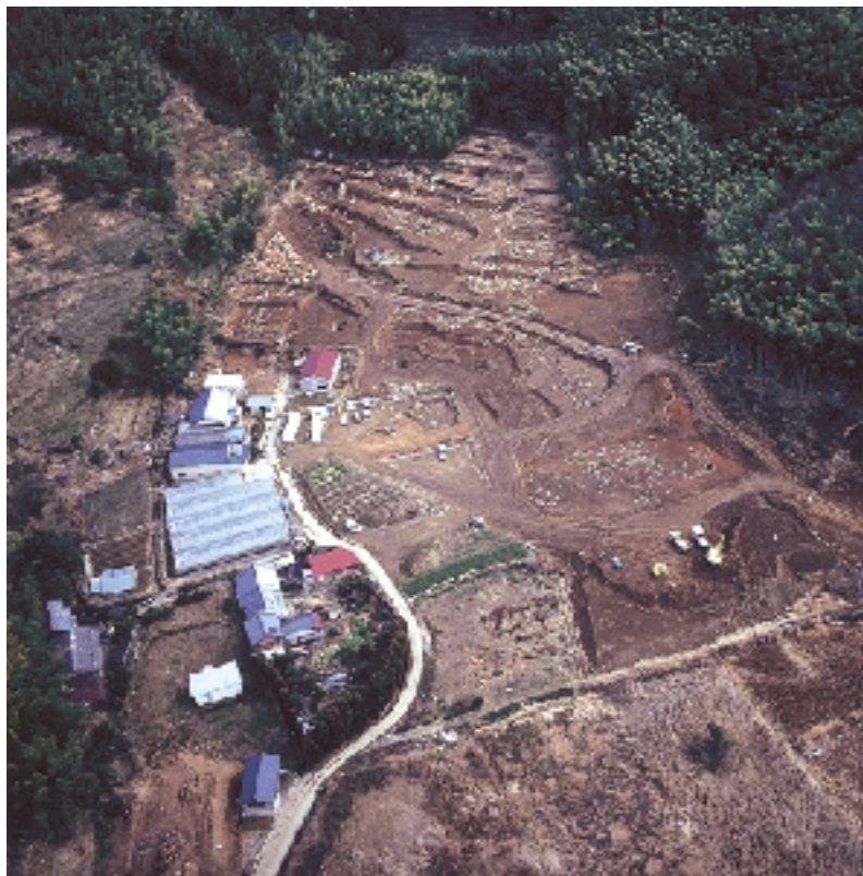
調査区完掘状況全景
