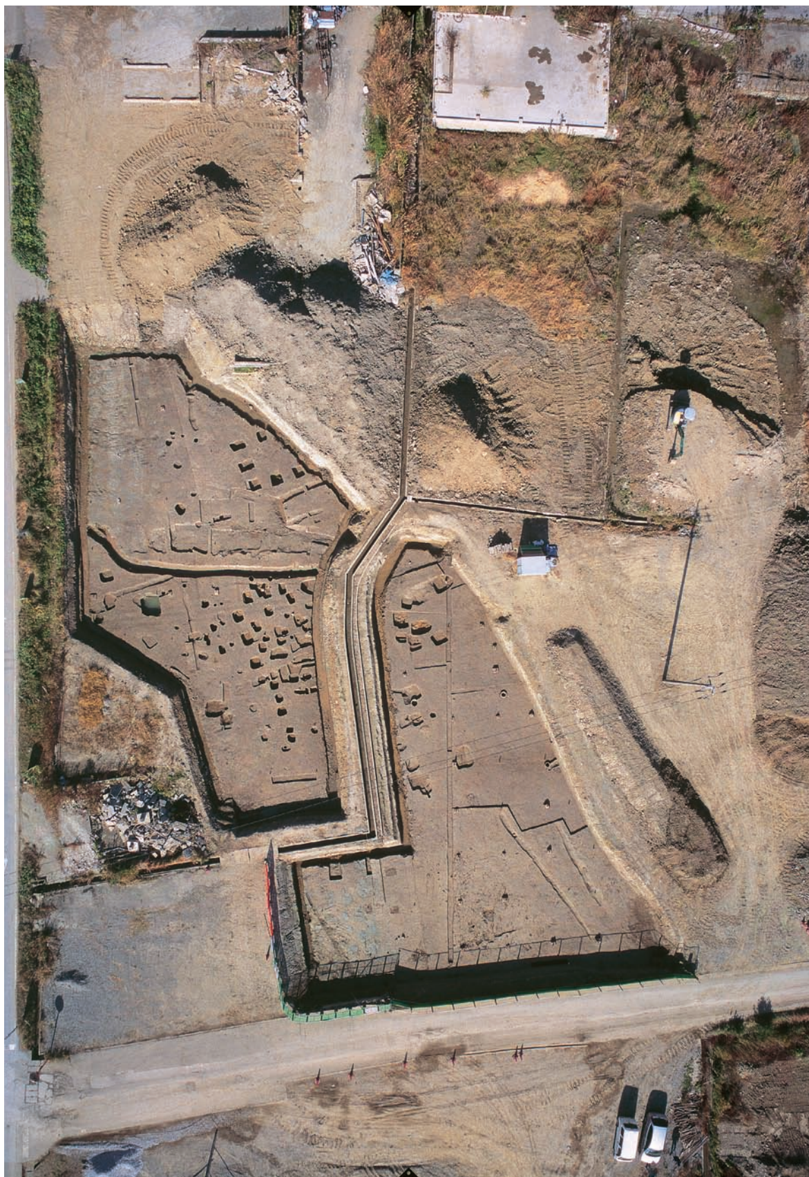
NW・NE区下層完掘状況
