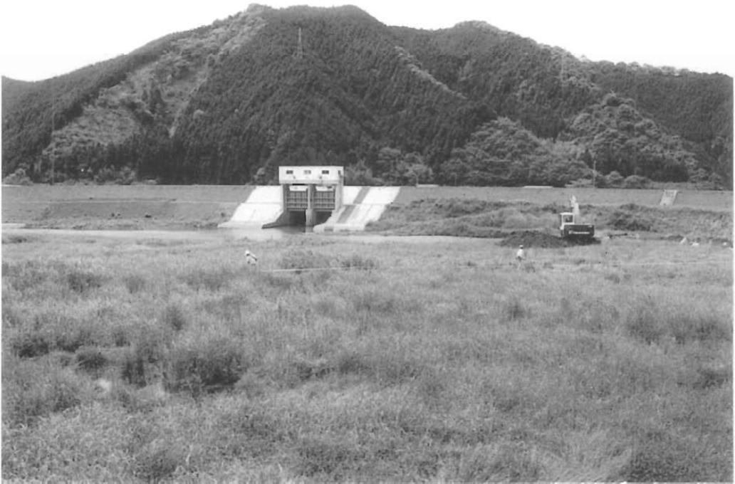
調査前全景（北より）
