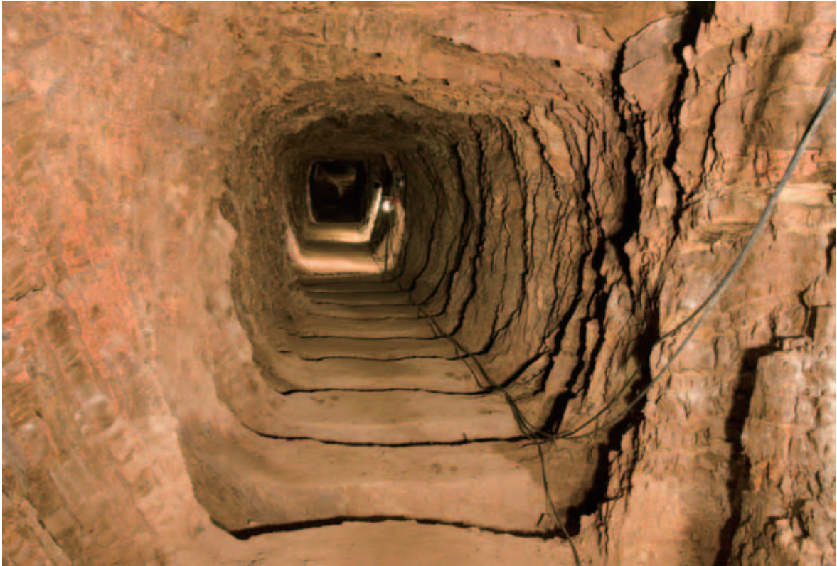
坑道 A・B 区完掘状況(北側入口から)
