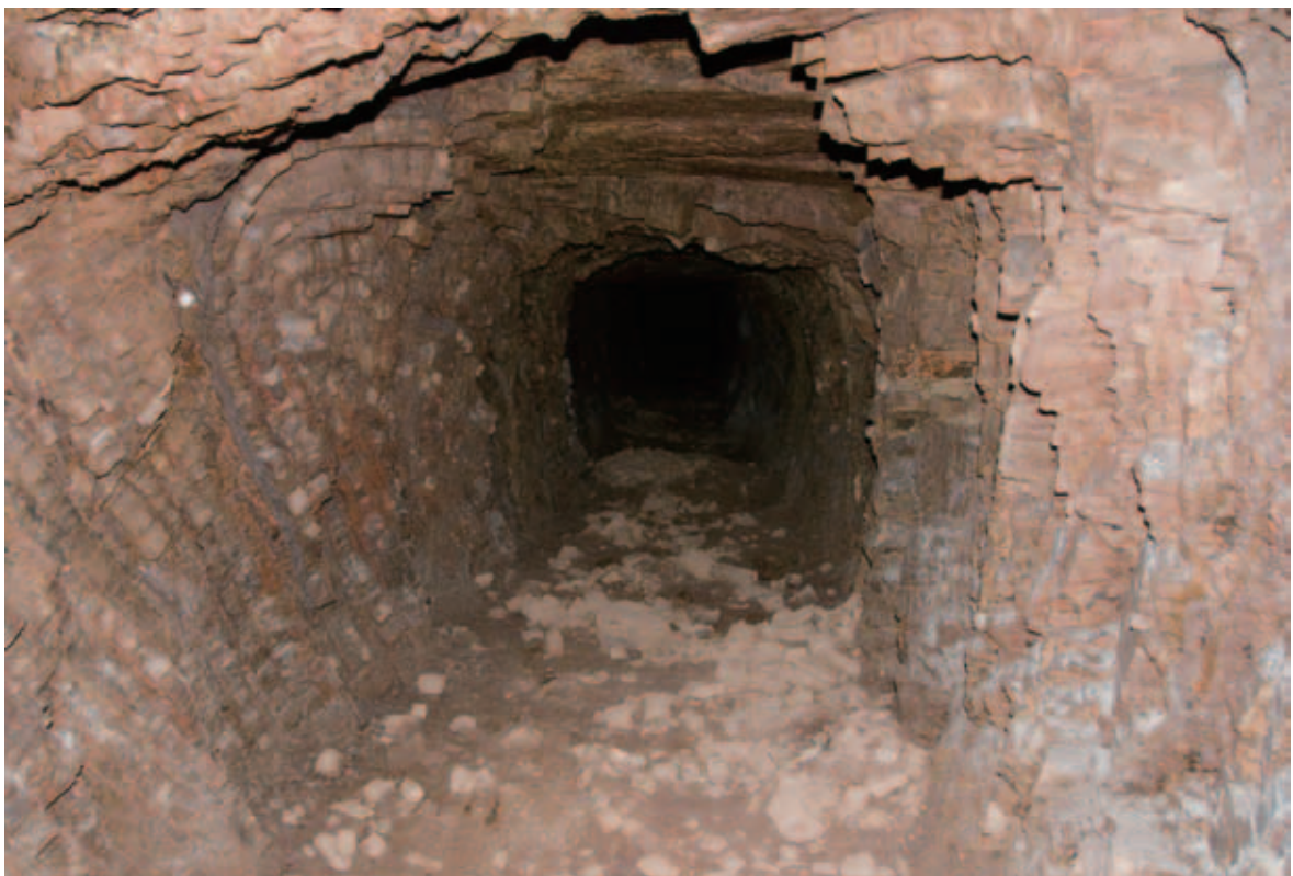
坑道 A 区調査前の状況(北側入口から)
