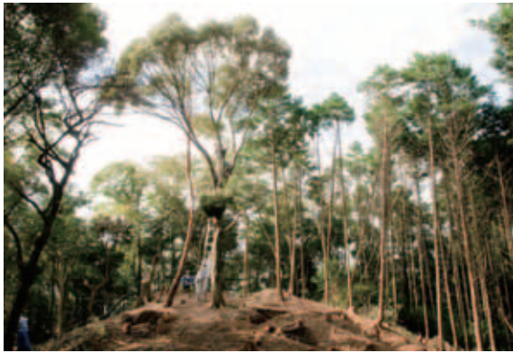
作業風景1(枝の伐採)
