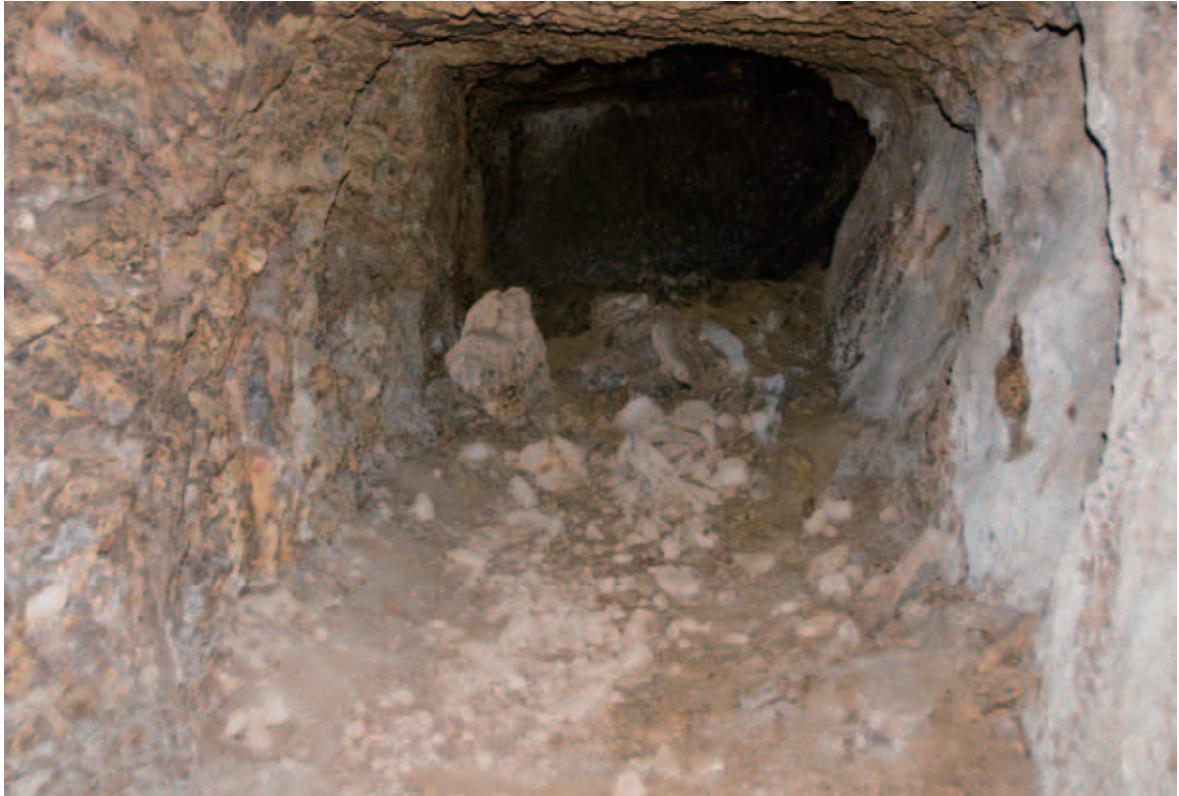
坑道 C 区調査前の状況
