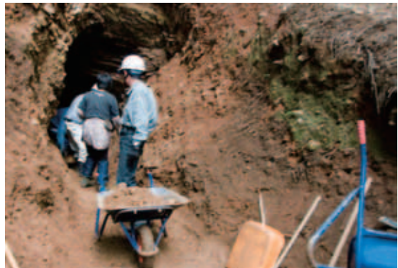
作業風景6(坑道北入口の掘削)
