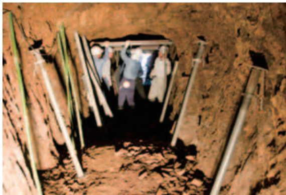
作業風景3(坑道天井の補強)
