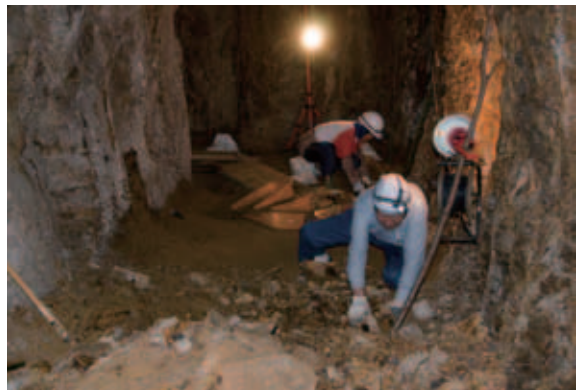
作業風景4(坑道 A 区の掘削)
