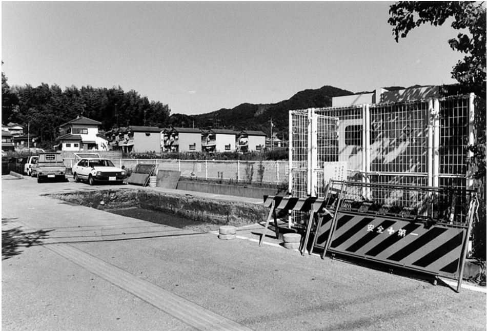
A-I区 (南東から)
