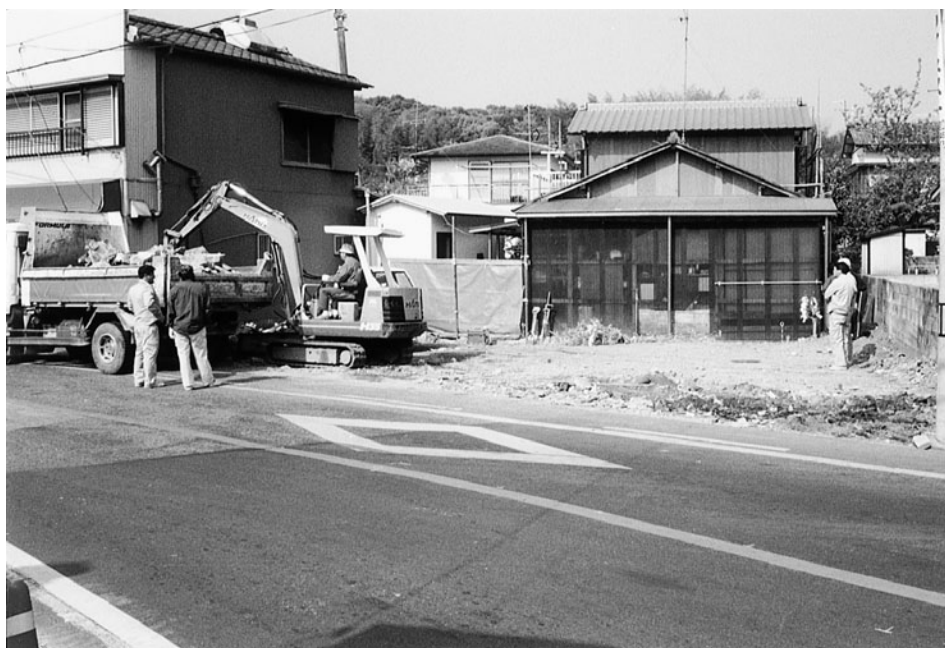
C区 TR-1 調査地（北東から）
