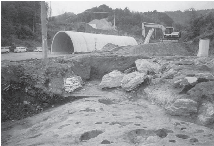
写真50 近世遺構面と1号岩陰（東から）
