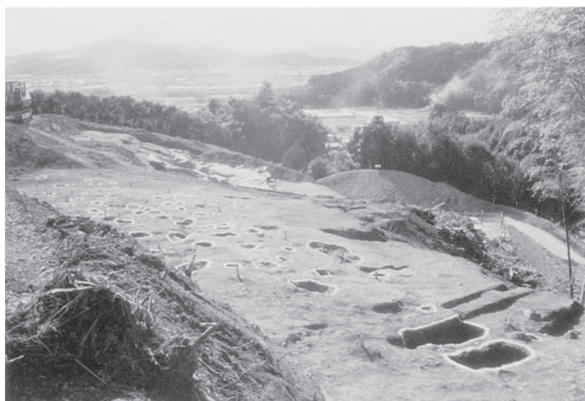
写真29 遺構面から平野部をのぞむ
