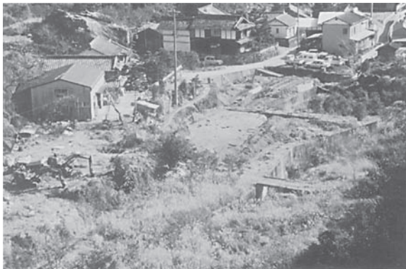
写真17 IV・V区遠景
