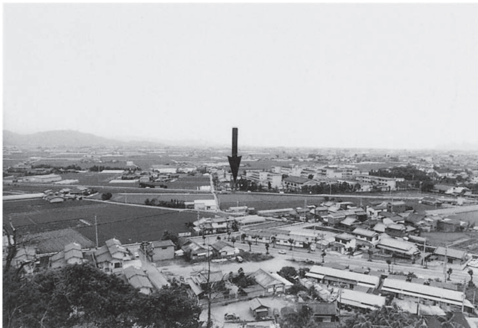
調査地遠景（矢印・北西山側より）
