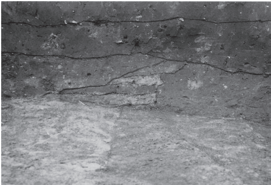
ST-12 北側壁体断面（東から）
