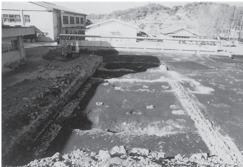
調査区南側旧校舎跡（東から）
