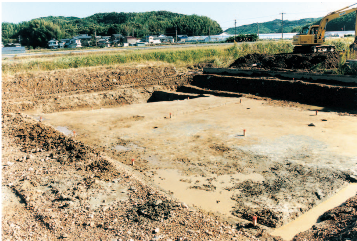
Ⅱ A 北区 完堀状況 (北西から)
