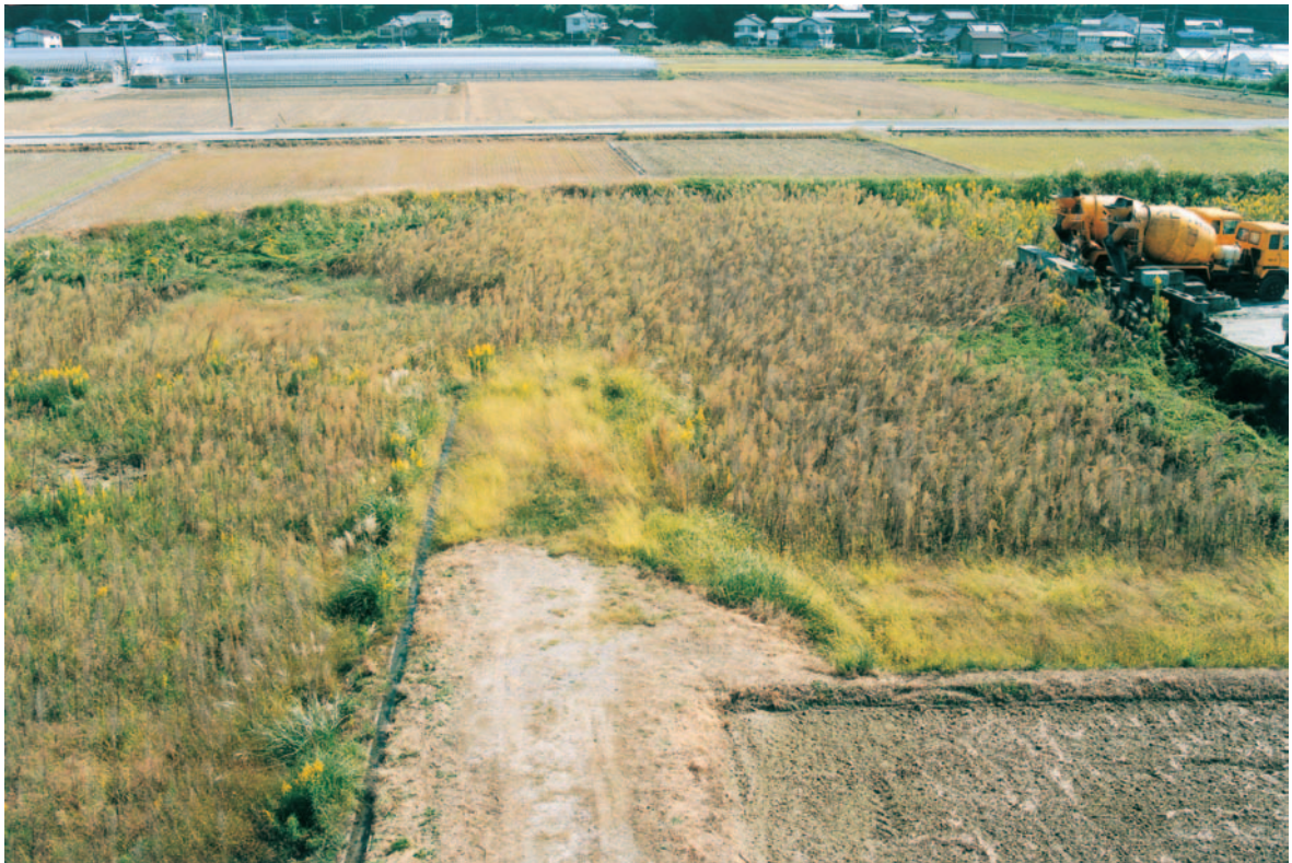
調査前風景 西から (ⅡA・C・D区)
