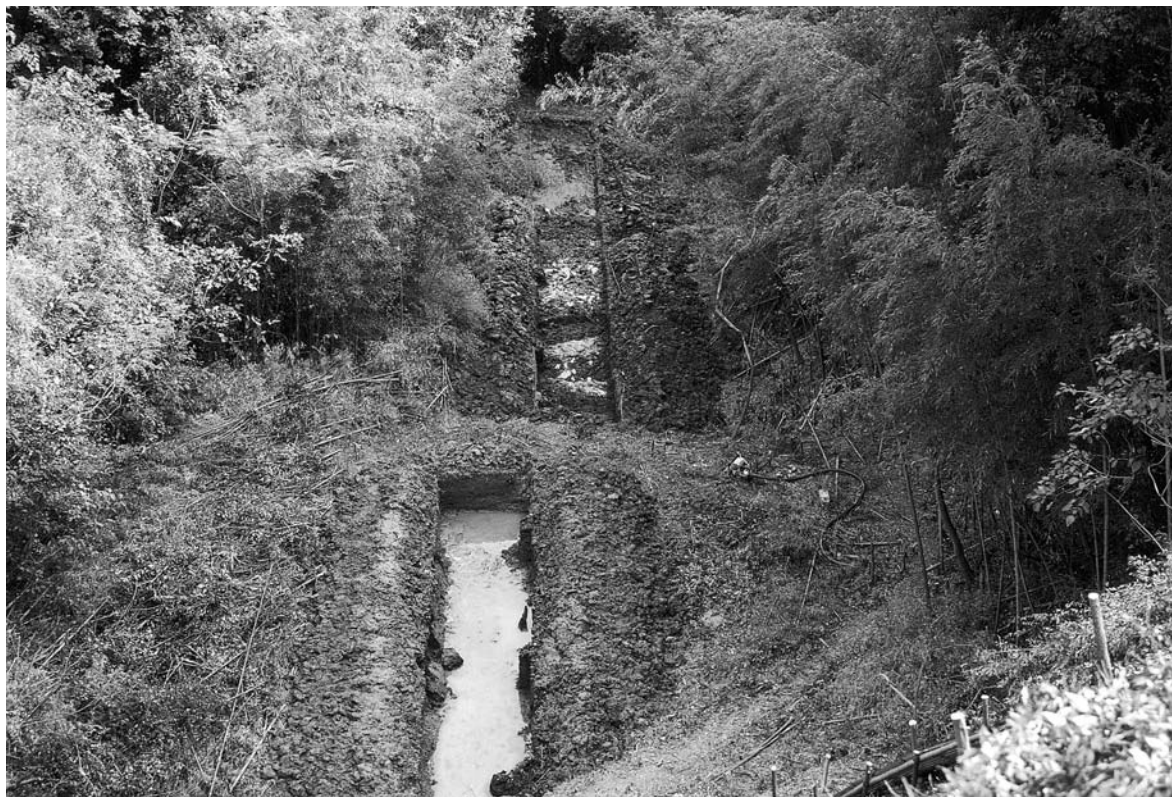
B・Cトレンチ完掘
