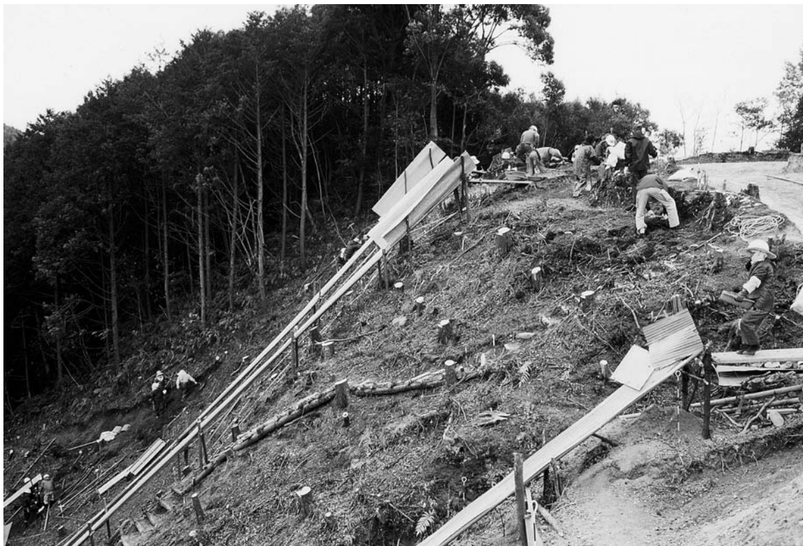
曲輪3作業風景
