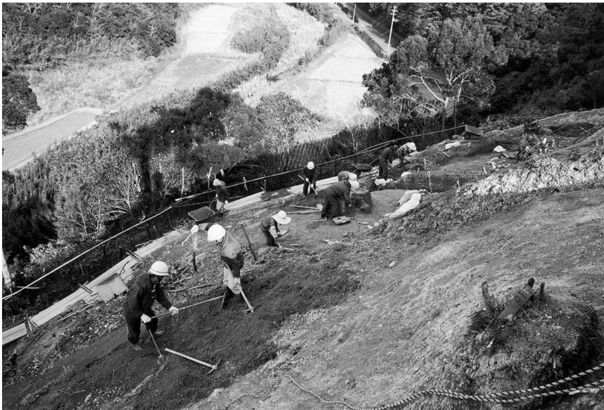
曲輪4作業風景
