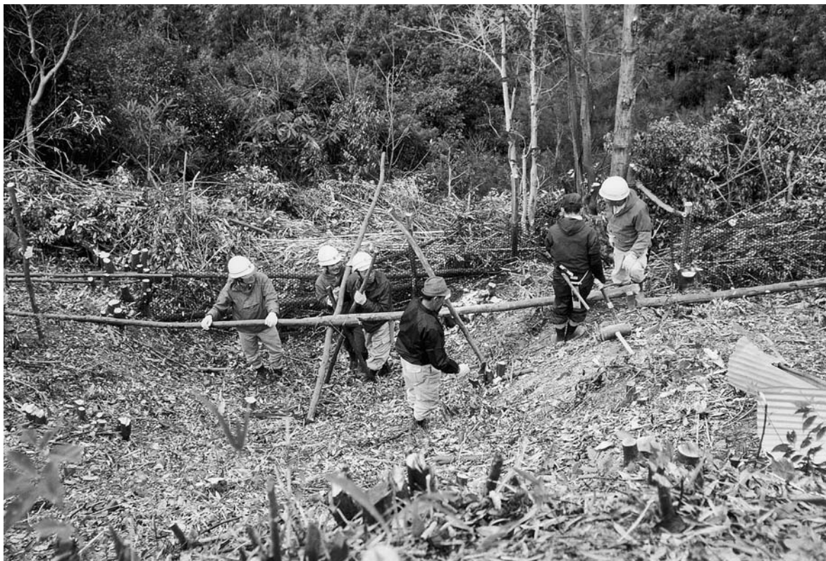
斜面部土留め作業風景
