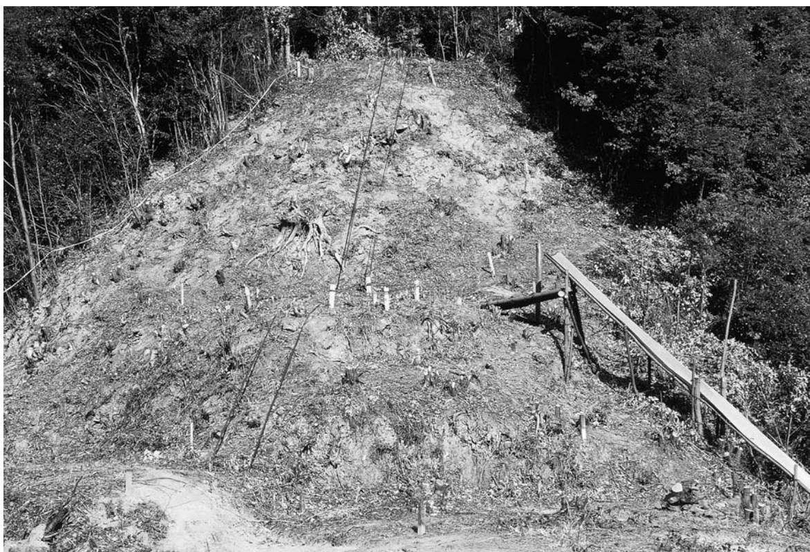
切岸ベルト設定状況
