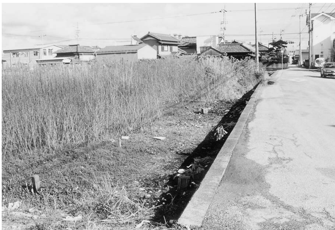
調査前 G3・4付近（西から）
