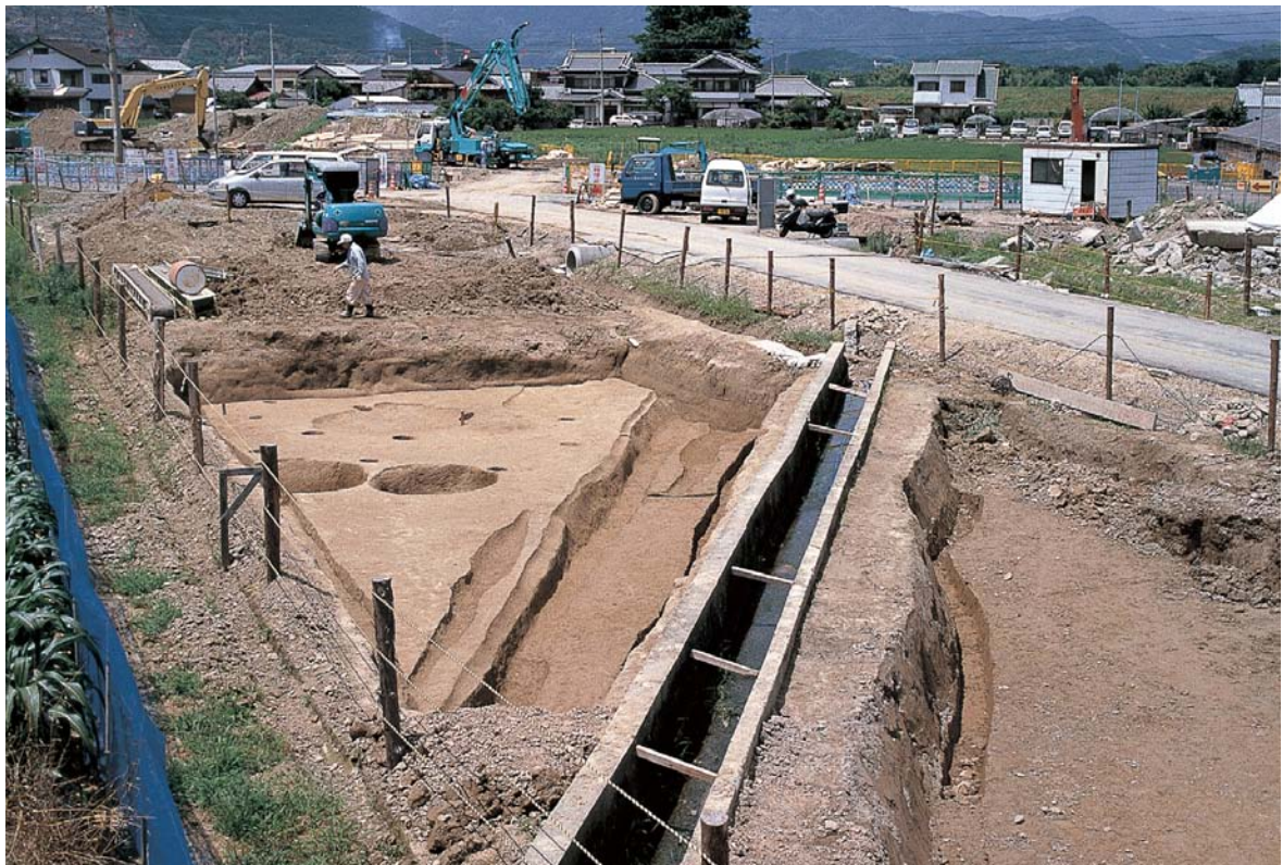
第 I 調査地区西部遺構完掘状態（南より）
