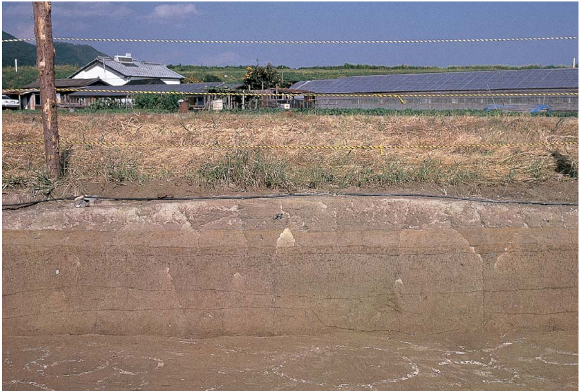
第Ⅱ調査地区東壁セクション1 (西より)
