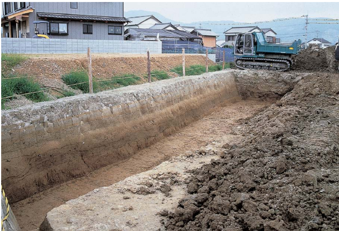
第 I 調査地区下層確認トレンチ (南より)
