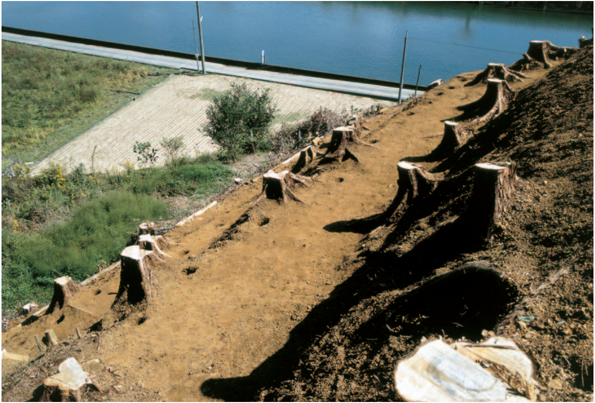
犬走り状遺構4 (SD - 4)完掘状態(西より)
