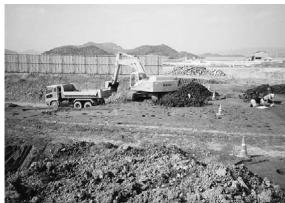
I4区 掘削工事に追われる調査
