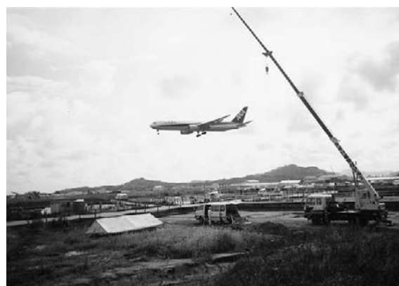
C5区 空中写真測量
