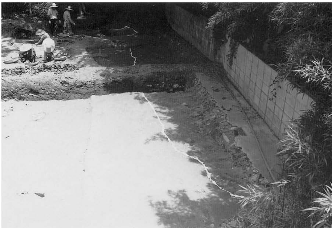
I区SD1検出状況（南より）
