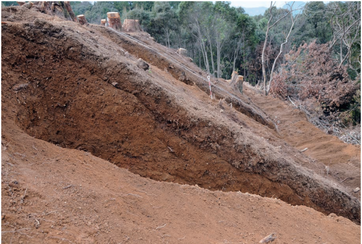
北斜面トレンチセクション(東より)
