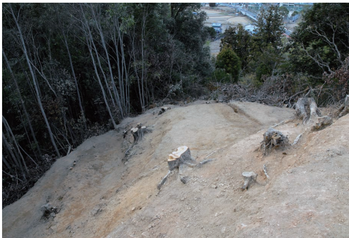
平場2完掘状態(南東・平場1より)
