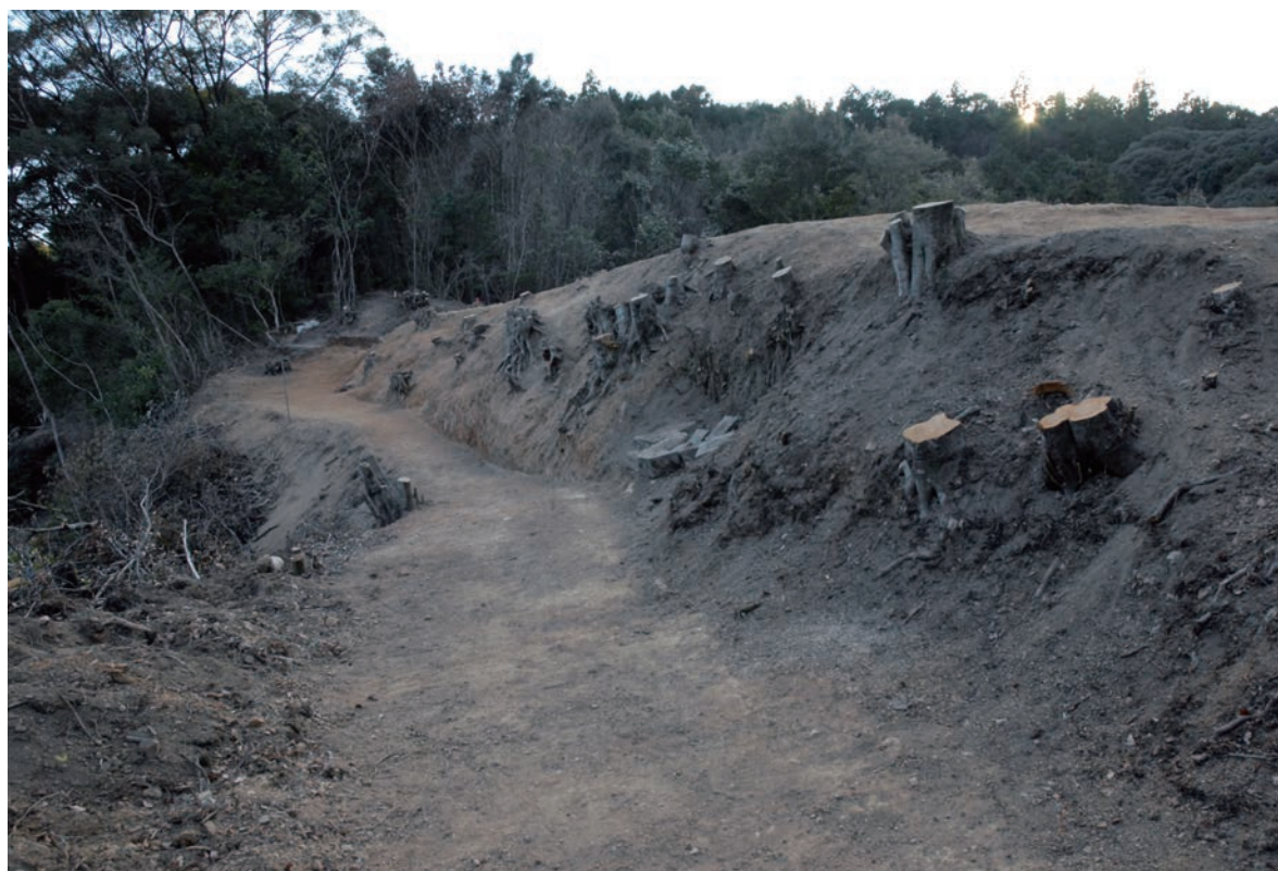
東斜面完掘状態(北より)
