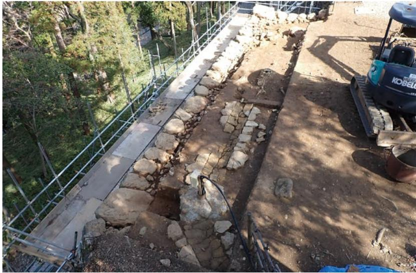
写真45 梅ノ段北側石垣3段目石尻及び栗石検出状態(R74・75面南西より)
