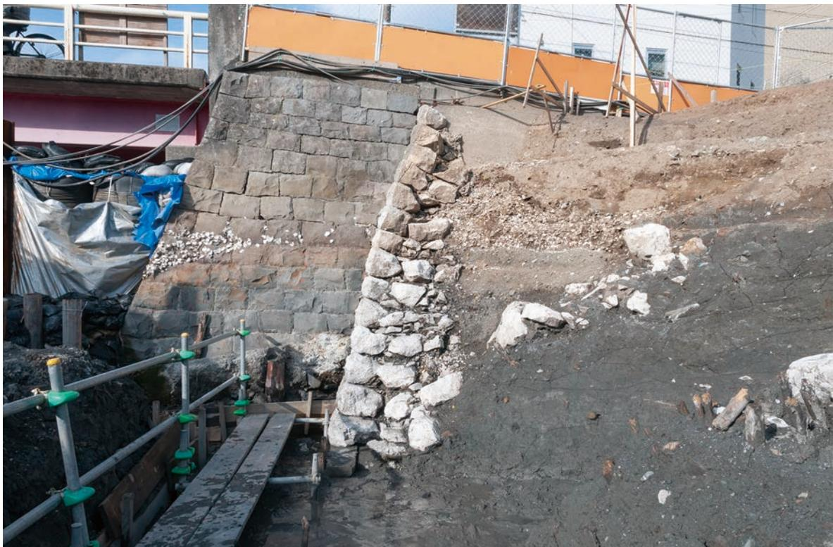
写真42 亀甲積み石垣断面(南より)
