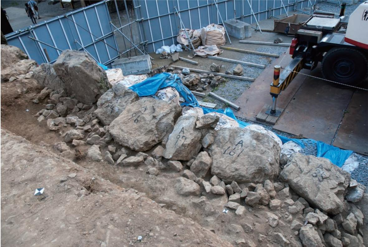
西面石垣c～c'ライン(南側)築石・裏込め・盛土の状態(北東より)
