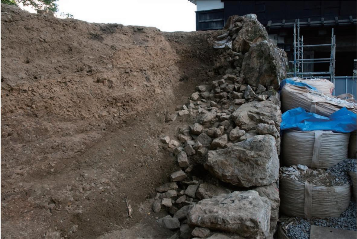
先行解体範囲石垣背面断面の状態(北西より)
