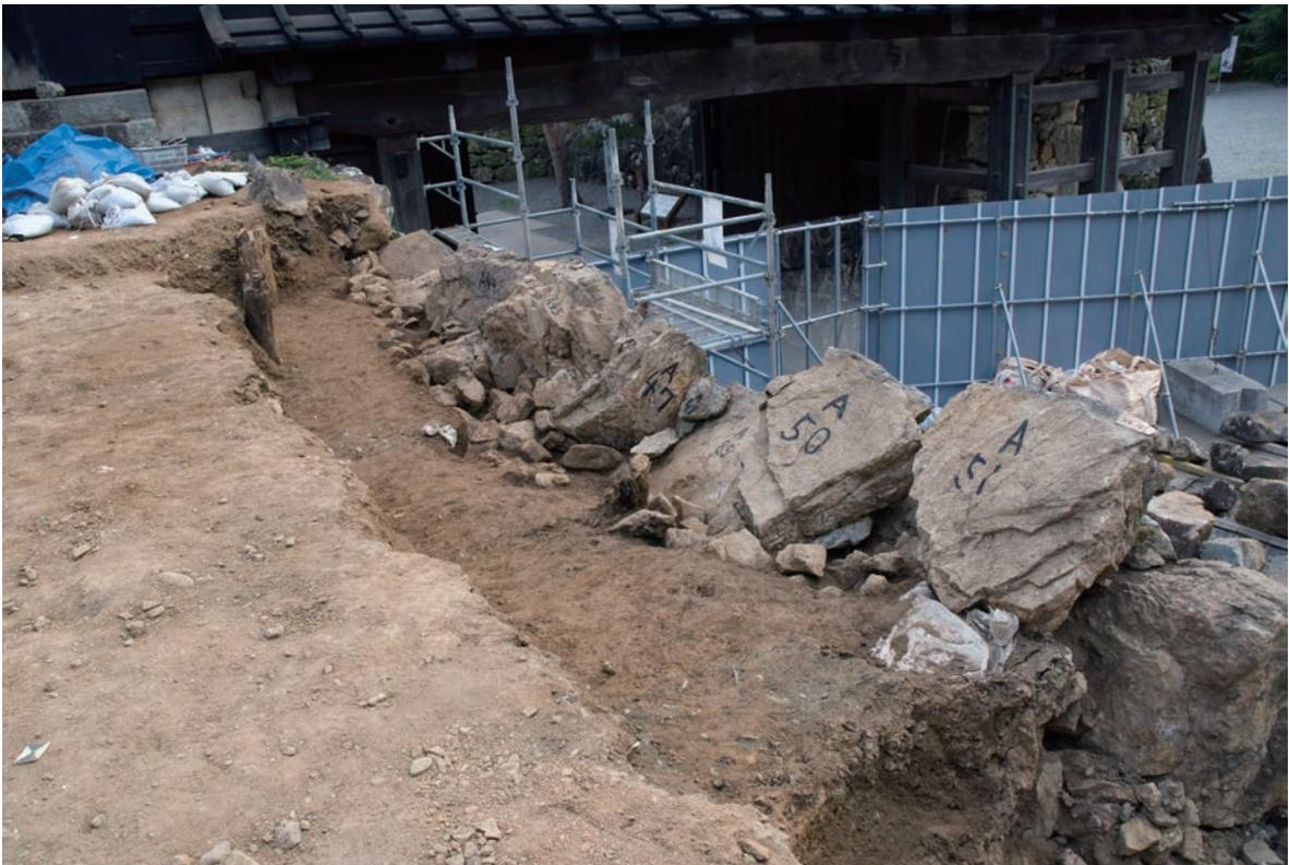
西面石垣a～a'ライン(南側)築石・裏込め・盛土の状態(東より)
