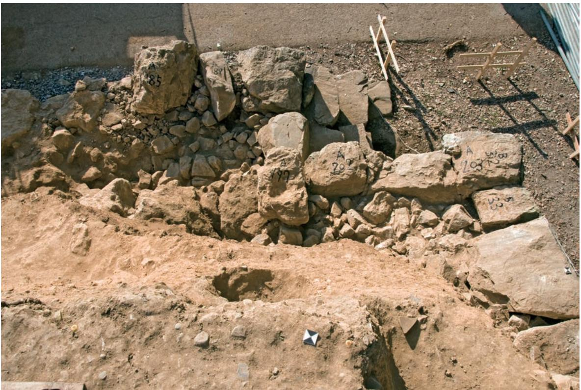
階段・北面石垣築石・裏込めの状態(平成25年度解体)(東より)
