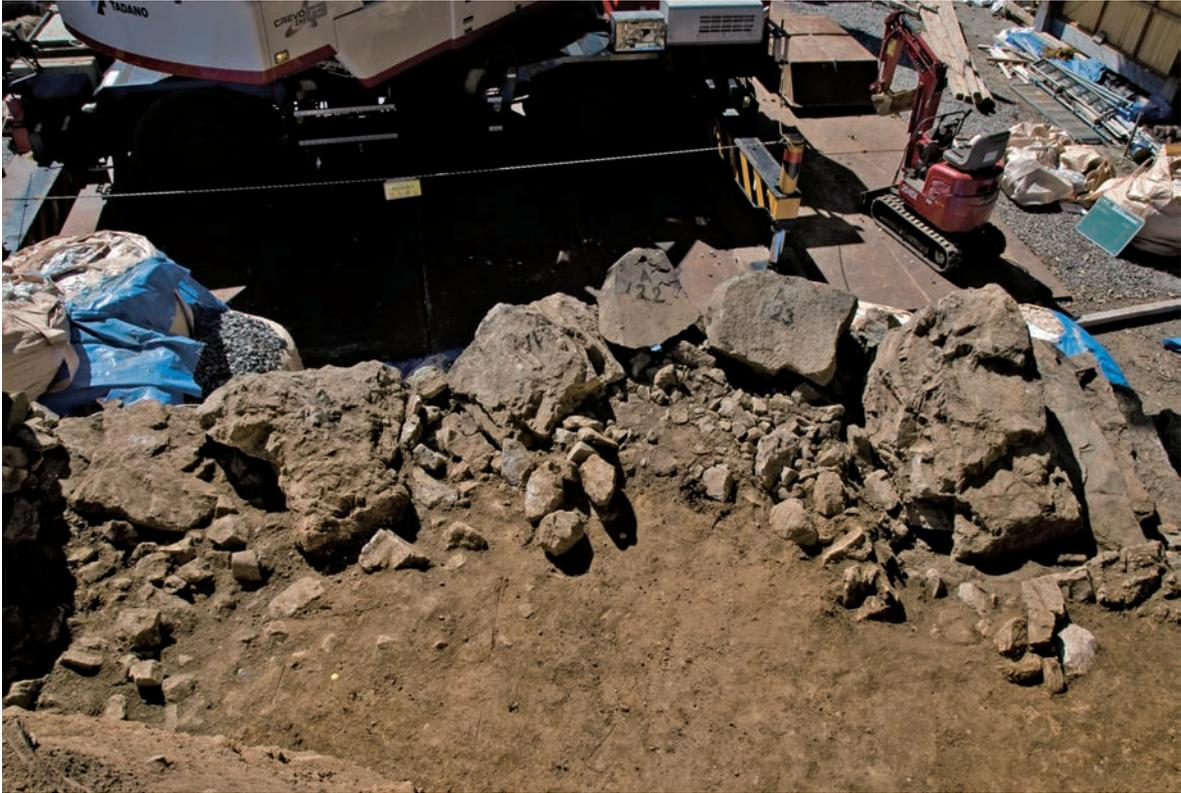
西面石垣c～c'ライン上段(北側・先行解体)築石・裏込め・盛土の状態(東より)
