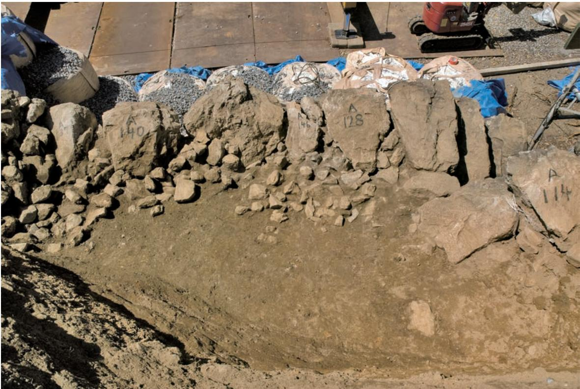
西面石垣c～c'ライン(北側・先行解体)築石・裏込め・盛土の状態(東より)
