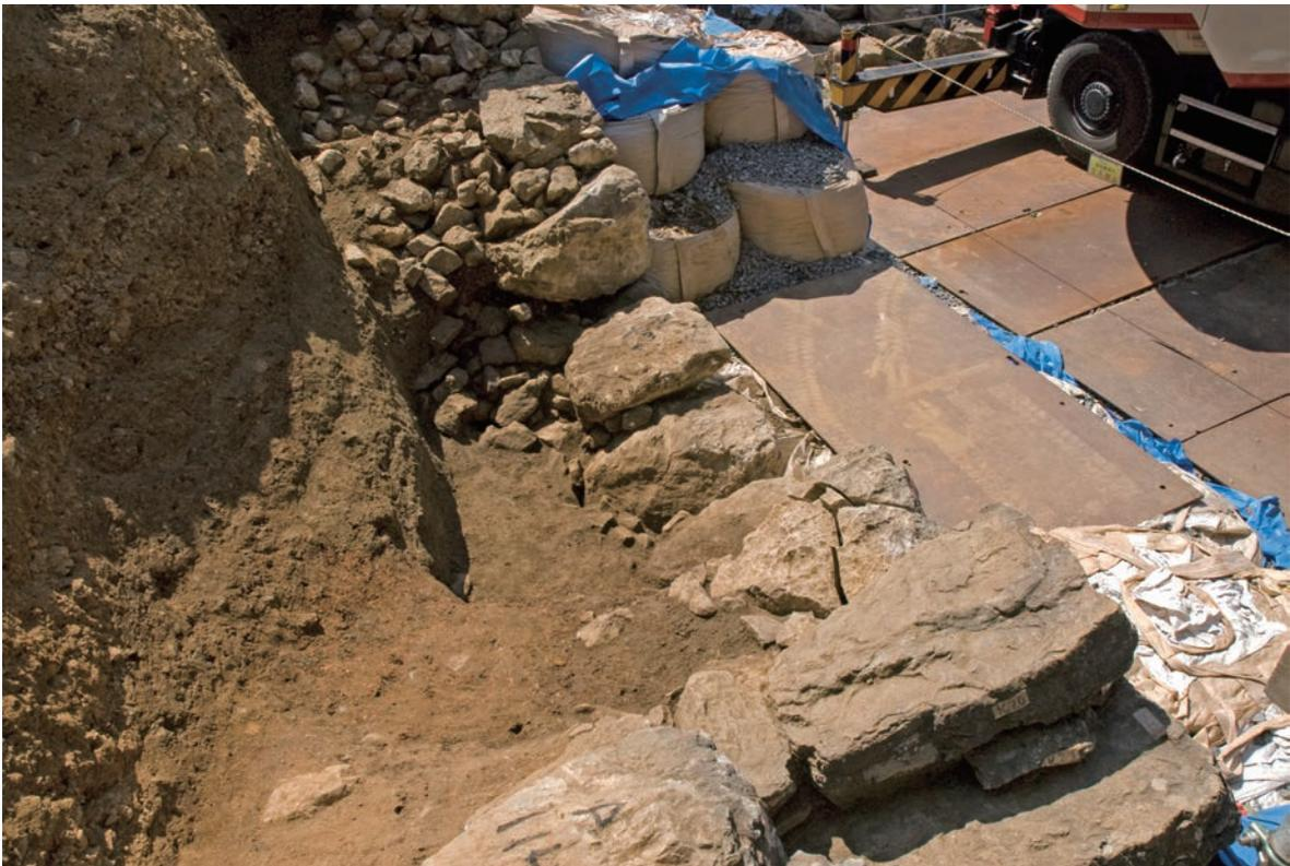
石垣 A143・144・148・149ライン（北側・先行解体）築石・裏込め・盛土の状態（北東より）
