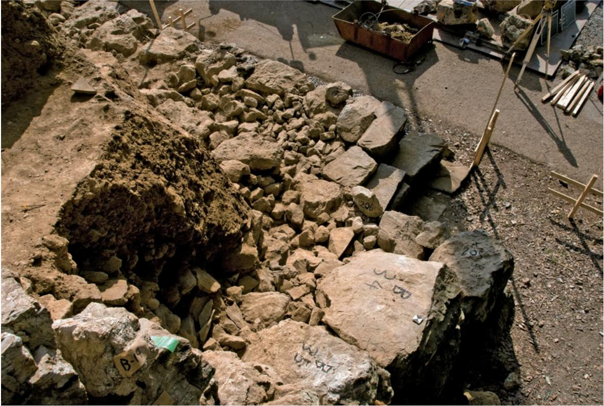
階段・北面石垣築石・裏込めの状態(平成25年度解体)(北東より)
