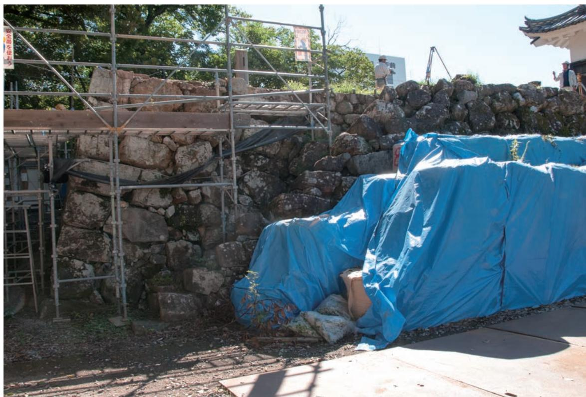
追手門東北矢狭間塀石垣西面改修作業風景及び大型土嚢設置状態（北西より）
