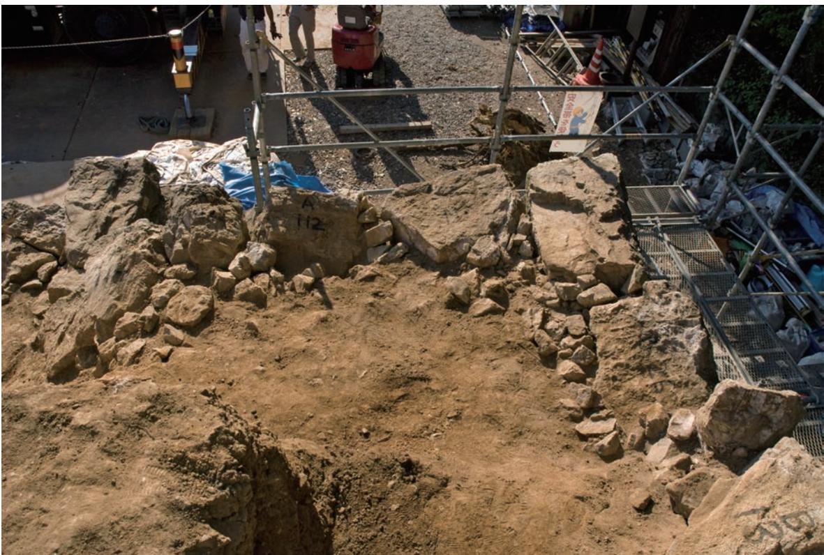
西面・北面石垣c～c'ライン(北側・隅角部)築石・裏込め・盛土の状態(東より)
