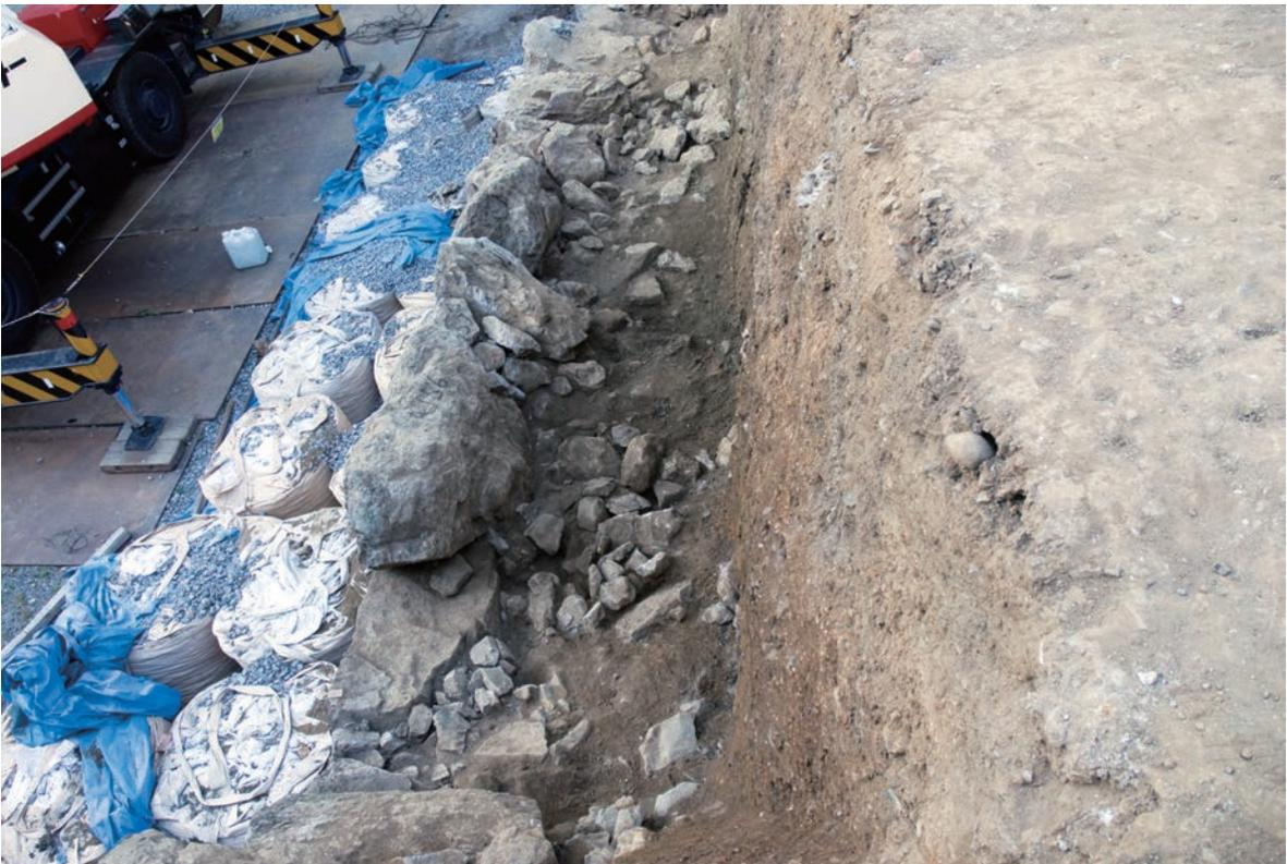
西面石垣d～d'ライン(南側)築石・裏込め・盛土の状態(南より)
