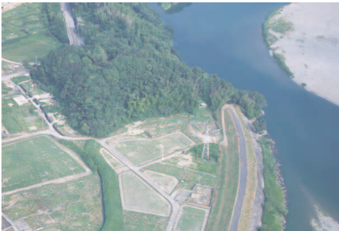
3 地点調査前の全景 南上空から
