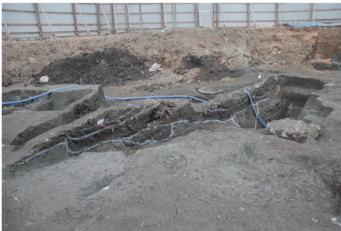
SK30, 31 セクション（南西より）
