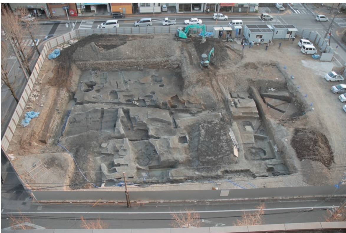
調査終了段階全景（北より）
