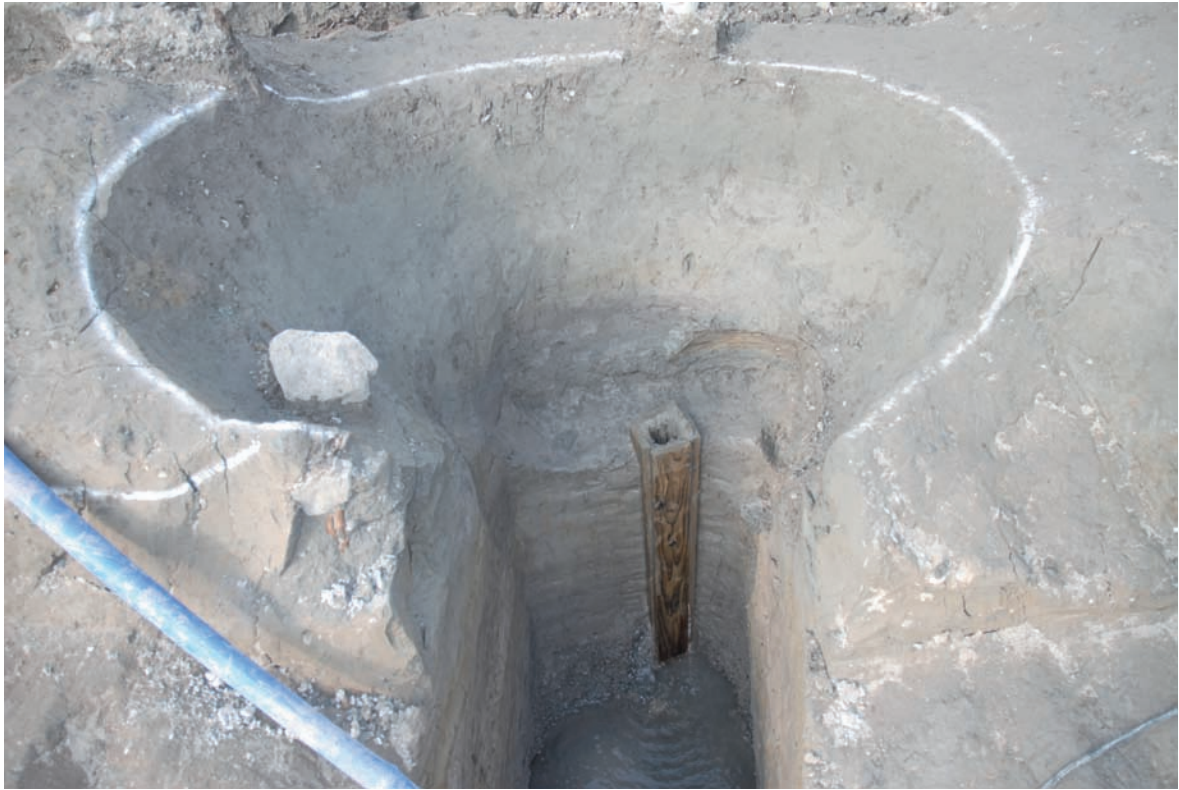
SE6 打込み部断面（南より）
