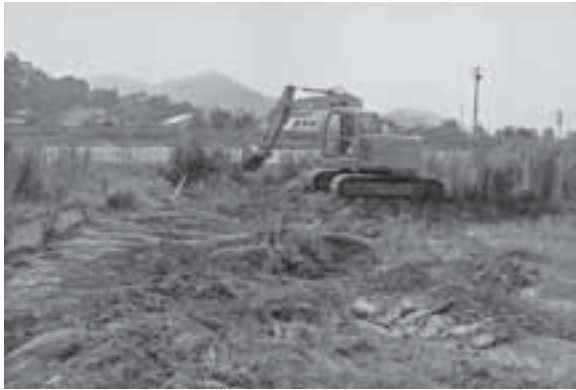
重機による掘削開始
