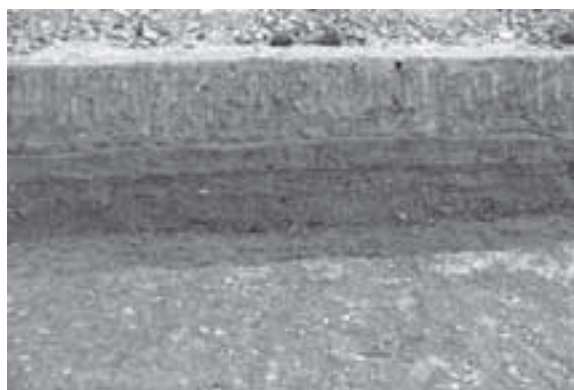
D区東壁中北を西から
