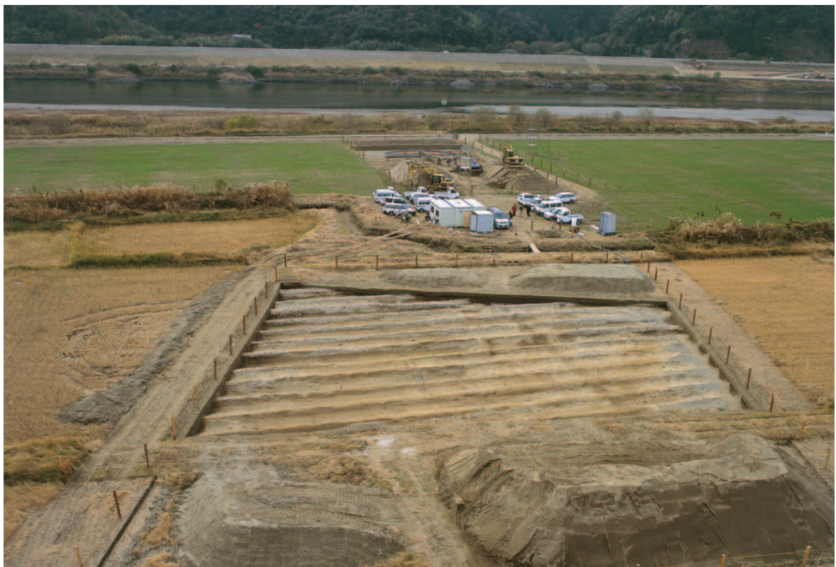
Ⅱ区遺構完掘状態(北東上空より)
