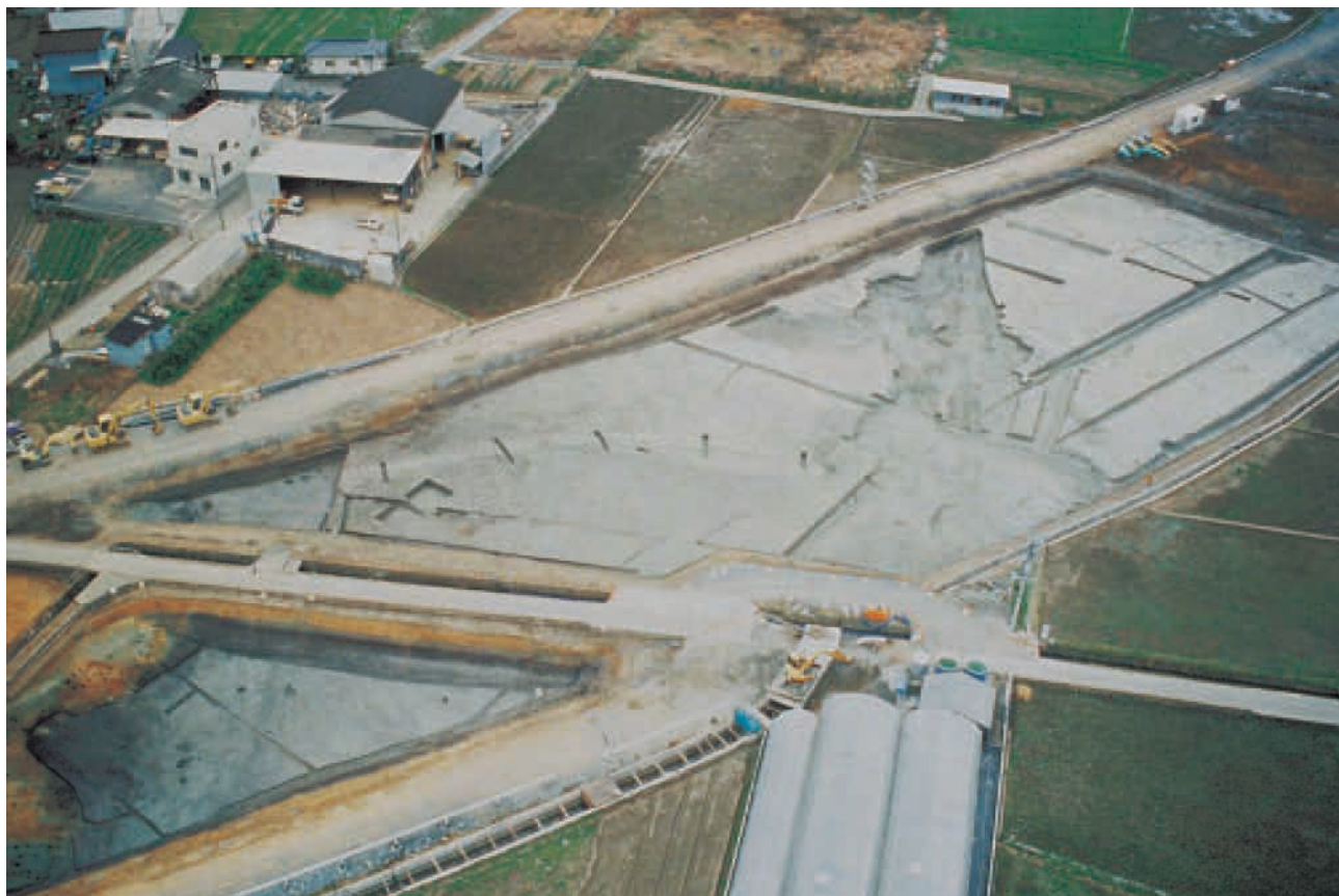
2 A区・3 B区完掘状態 (北西より)
