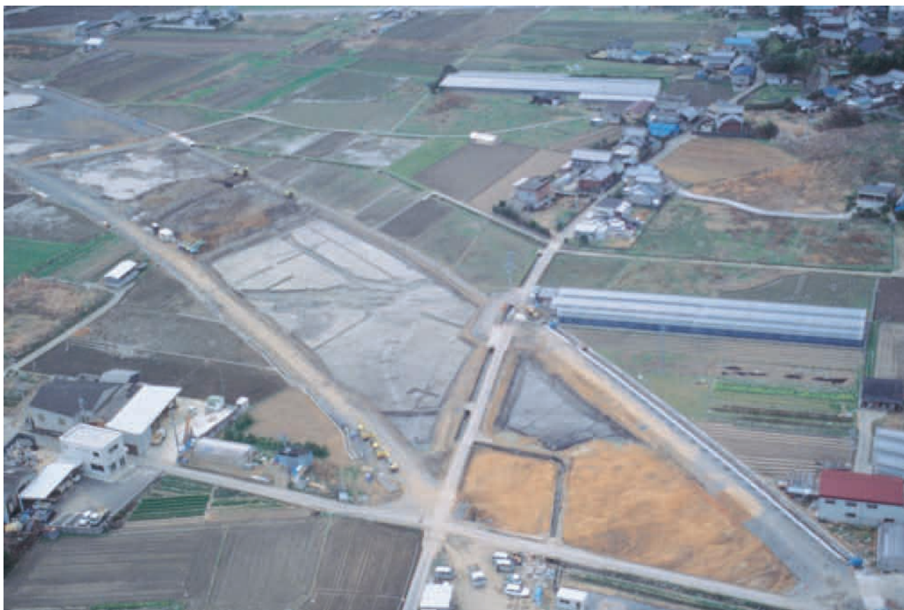
2A区・3A区・3B区完掘状態 (北東より)
