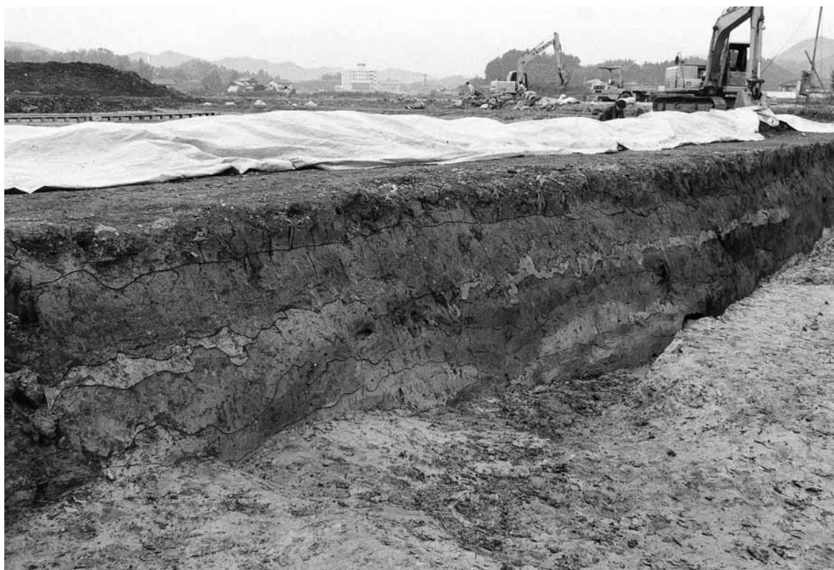
3B区 流路群バンク (北東より)
