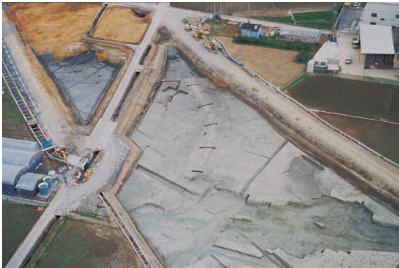
3B区完掘状態（南西より）
