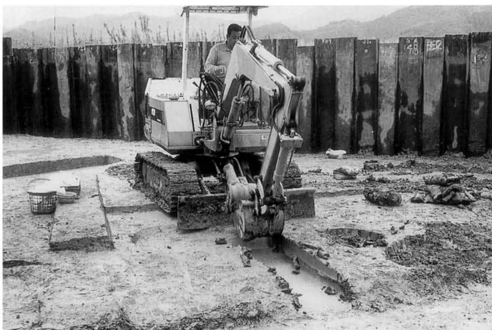
1区 調査後の断ち割り
