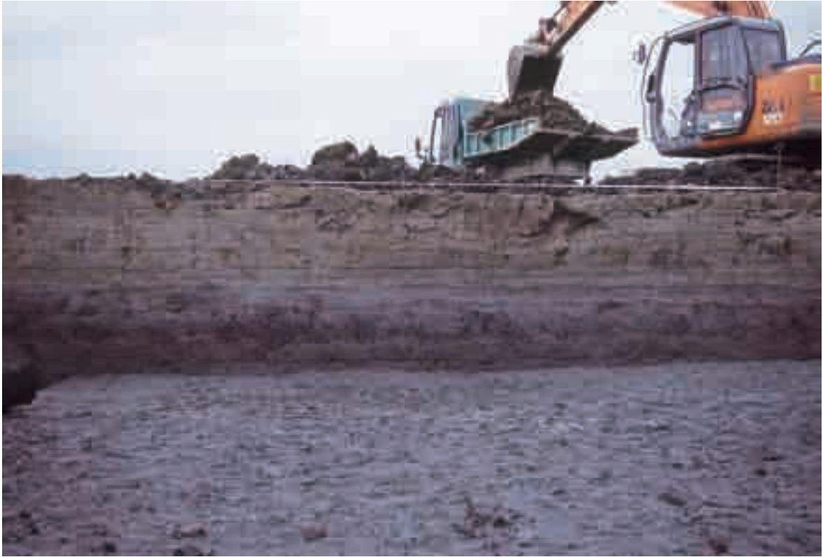
Ⅲ区 中央バンクセクション(南より)
