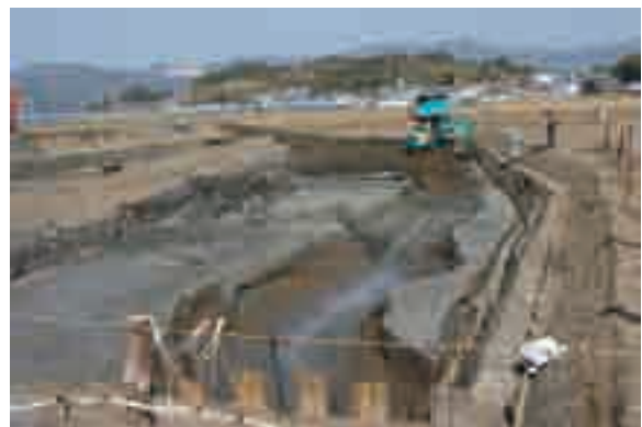
写真2-2 II区埋め戻し風景
