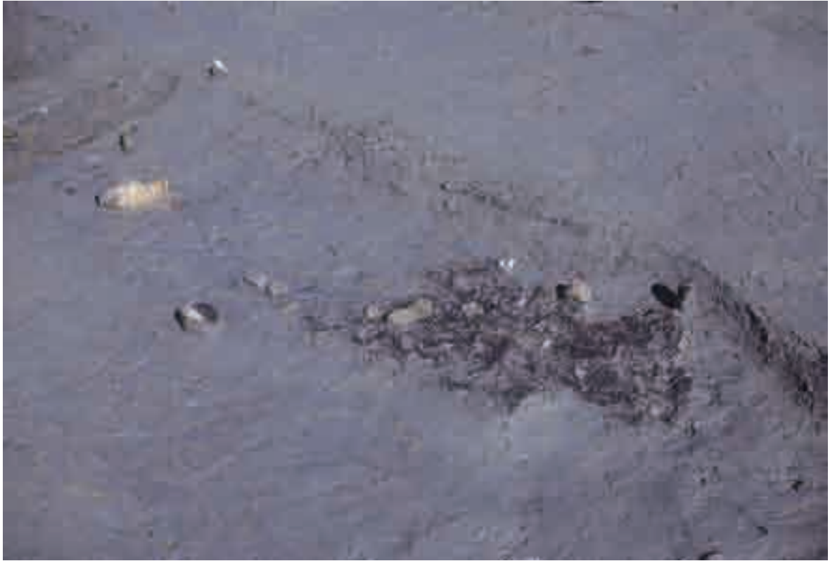
IV区 SD-5(南西より)
