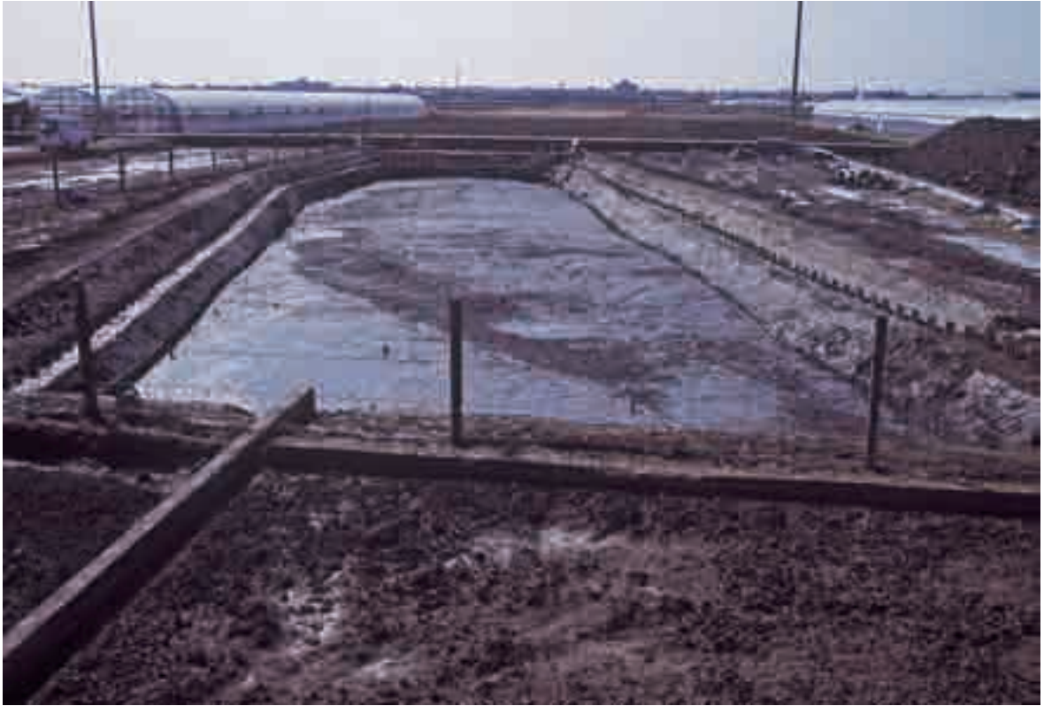
Ⅲ区 遺構検出状態(北より)
