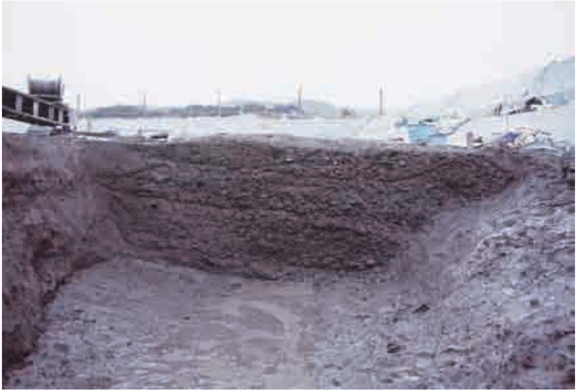
Ⅲ区 SR-4(南より)
