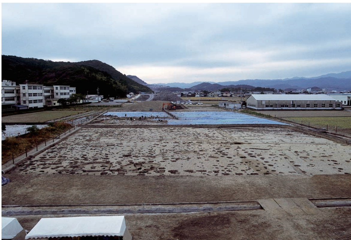
Ⅶ区W 遺構完掘状態(東より)
