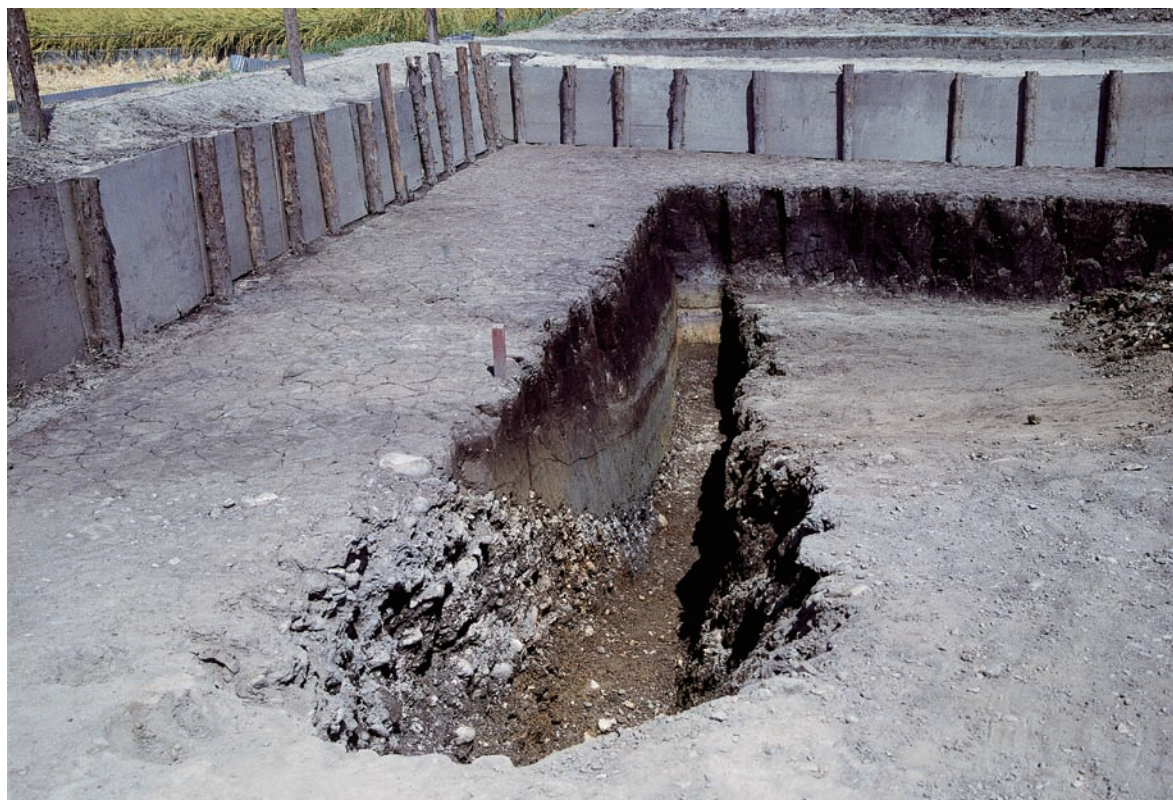
Ⅷ-4区 下層確認トレンチセクション(南西より)
