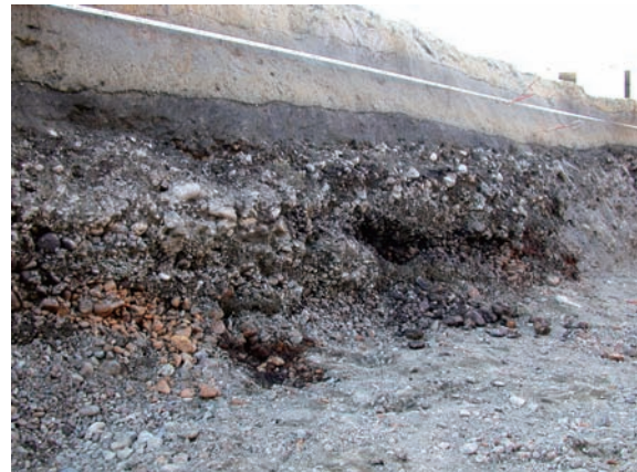
写真4-4 VI区深掘断面堆積状況4
