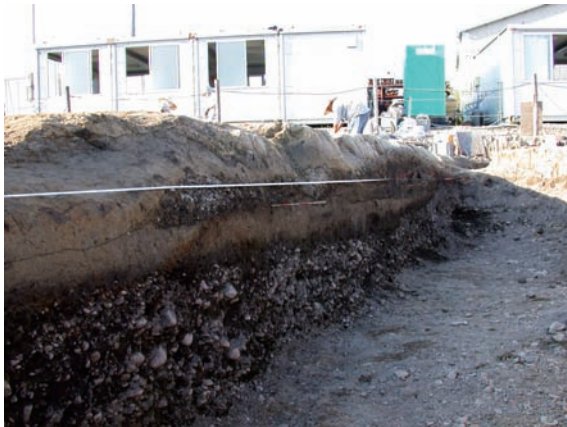
写真4-3 VI区深掘断面堆積状況3
