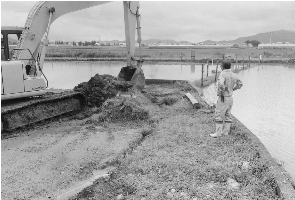
4 B 区表土掘削状態
