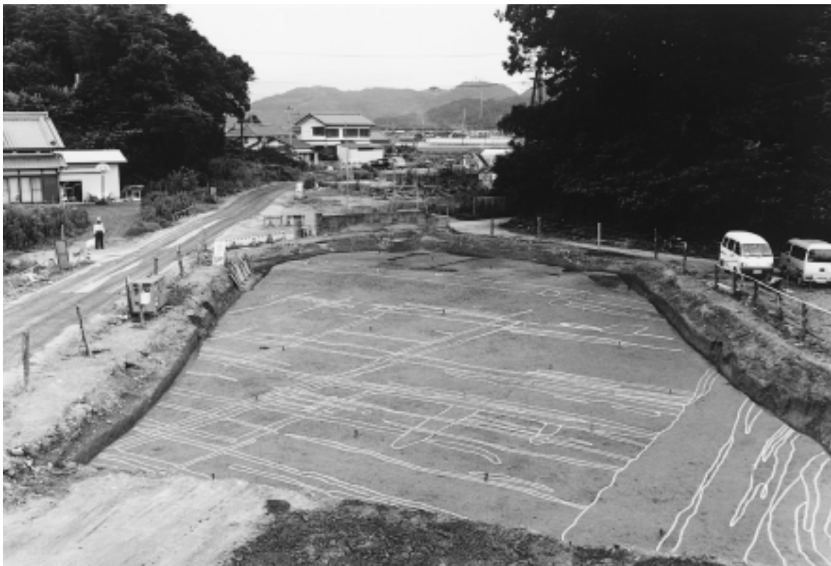
E区東部中世遺構検出状態(西より)
