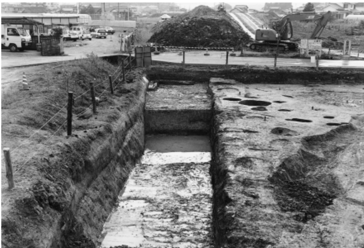
E区下層確認トレンチ(東より)
