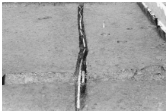
C区北東部暗渠 (南より)
