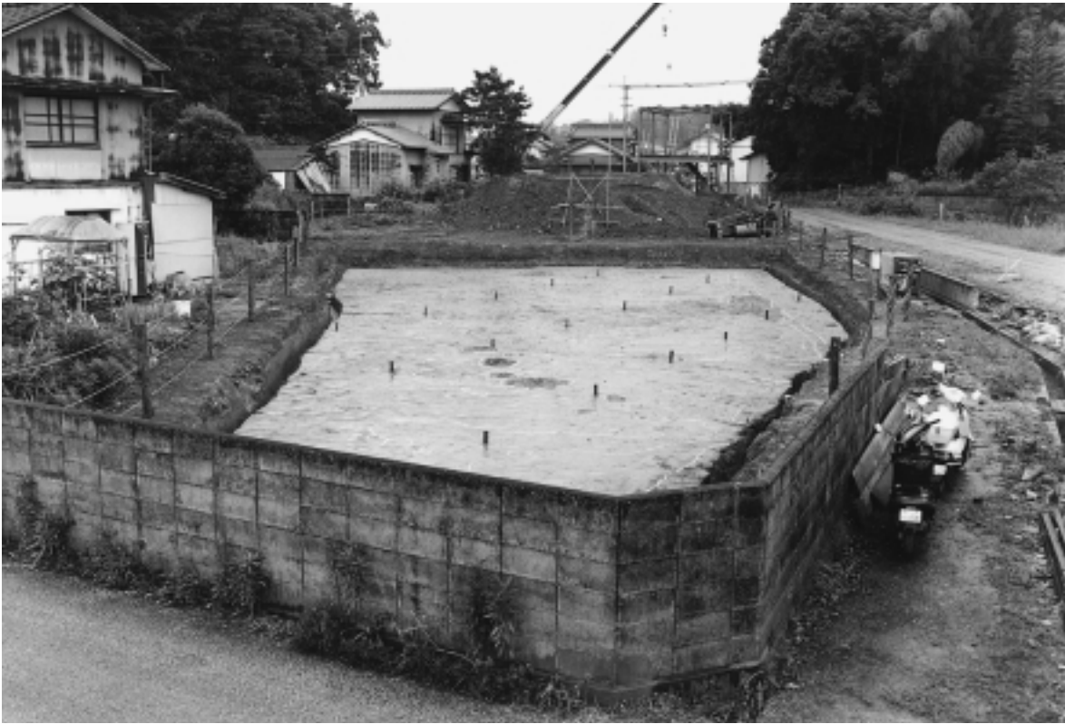
C区南東部近世遺構検出状態(東より)
