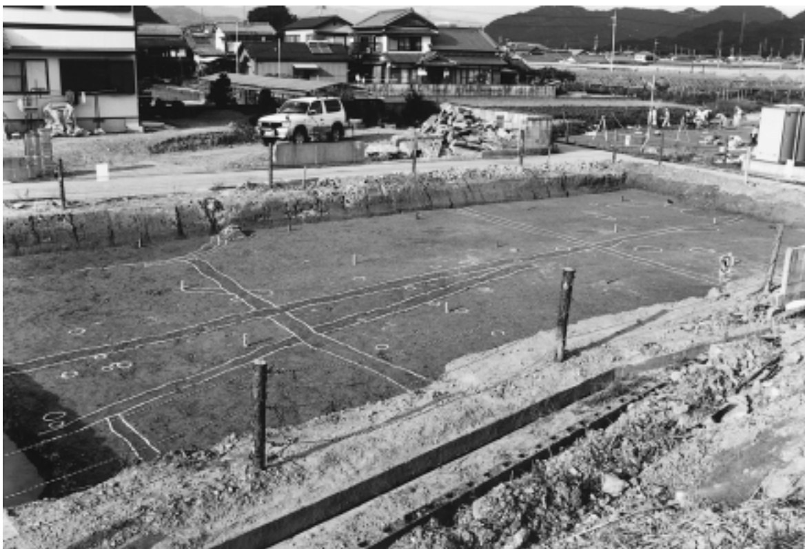
C区北東部遺構検出状態(南西より)
