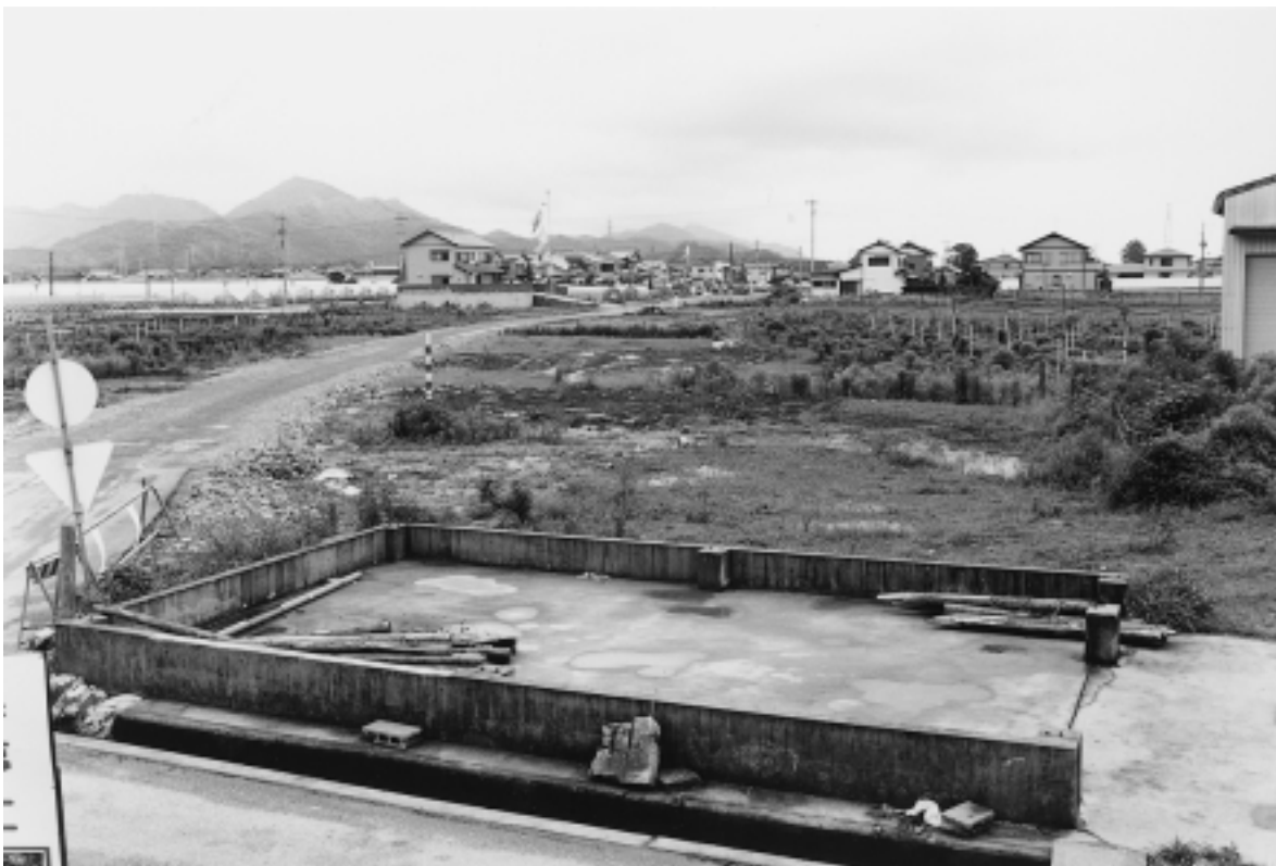
B区調査前全景2(西より)
