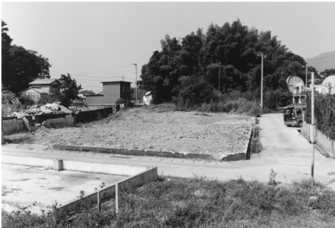
C区調査前全景(東より)
