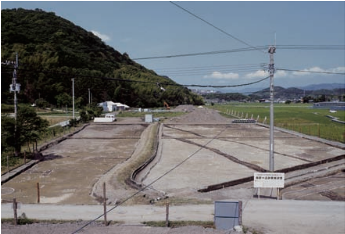
IV区E 遺構検出状態(東より)
