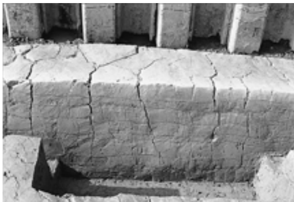
2区北壁セクション・東部（南より）
