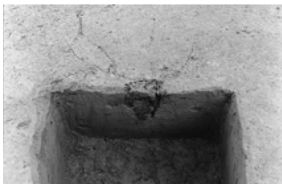
P1半裁セクション（西より）
