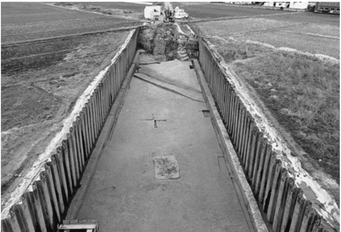
2区完掘状態（東より）
