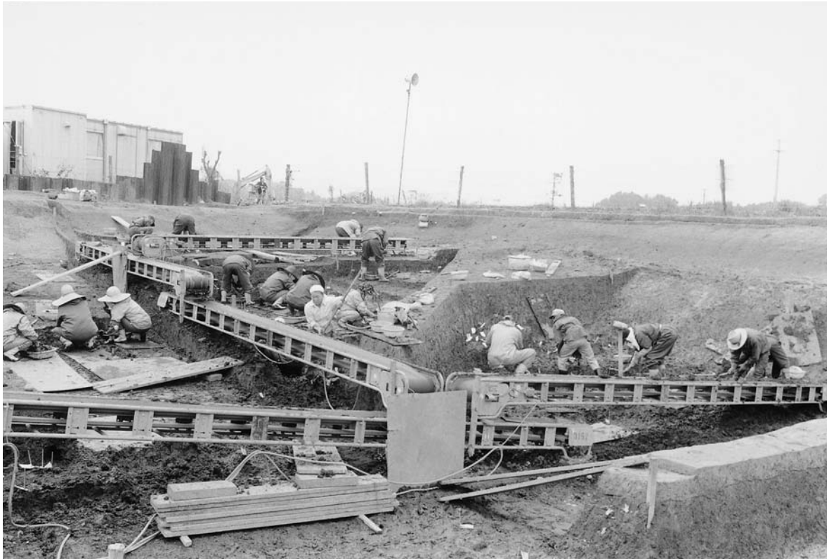
4 D区南西部調査状況
