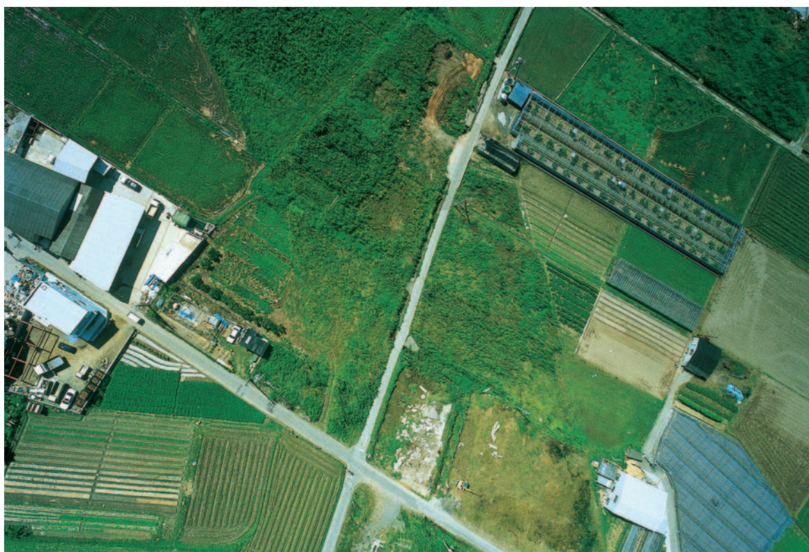
3区調査前状況（垂直・南東より）
