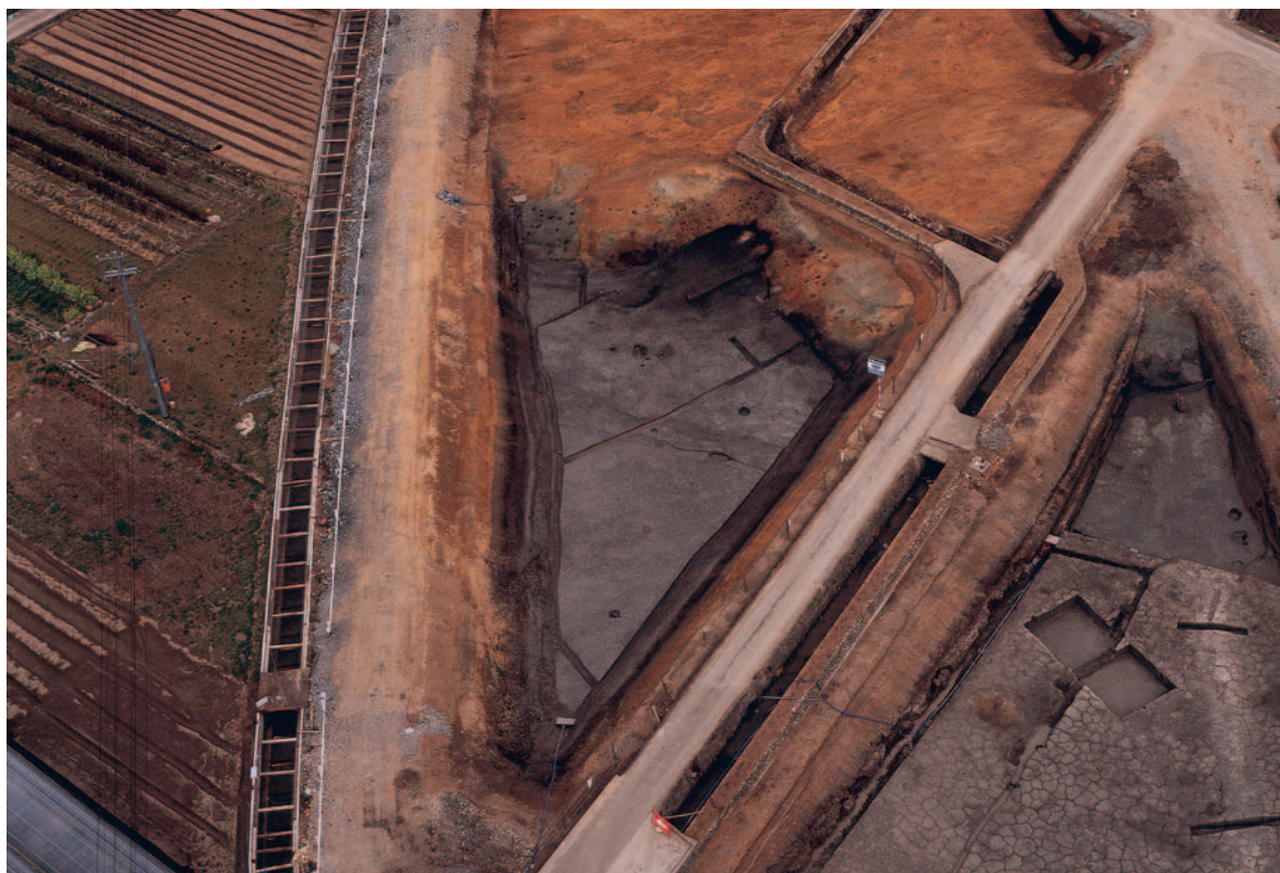
3A区完掘状況（南西より）
