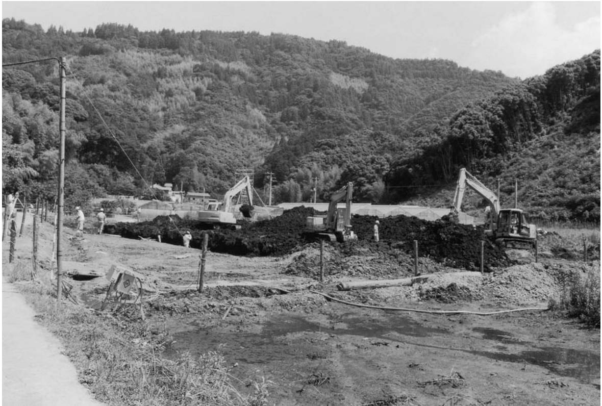
5 A区機械掘削状況
