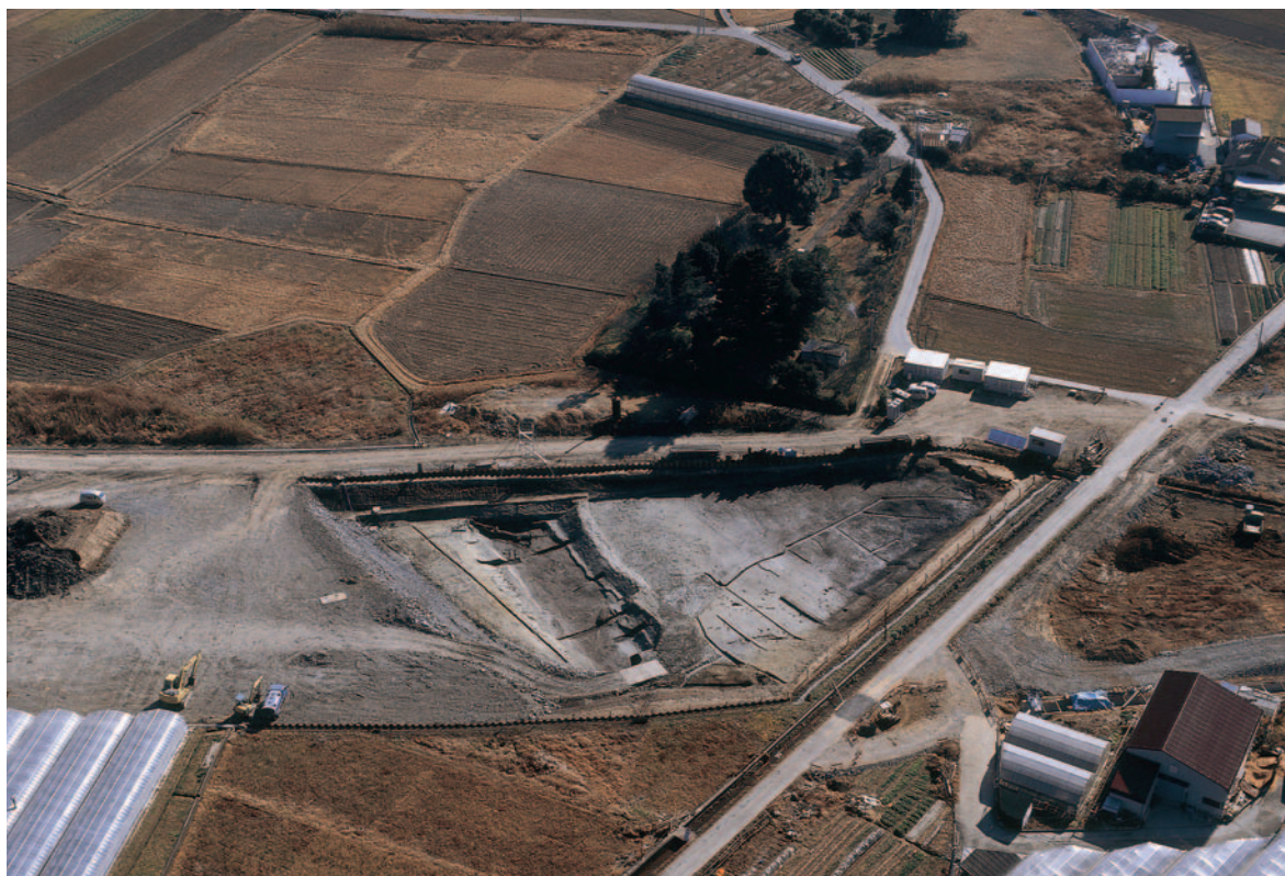
4C・4D区完掘状況（北西より）
