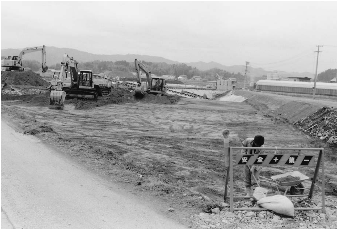
3 A区北西部調査状況
