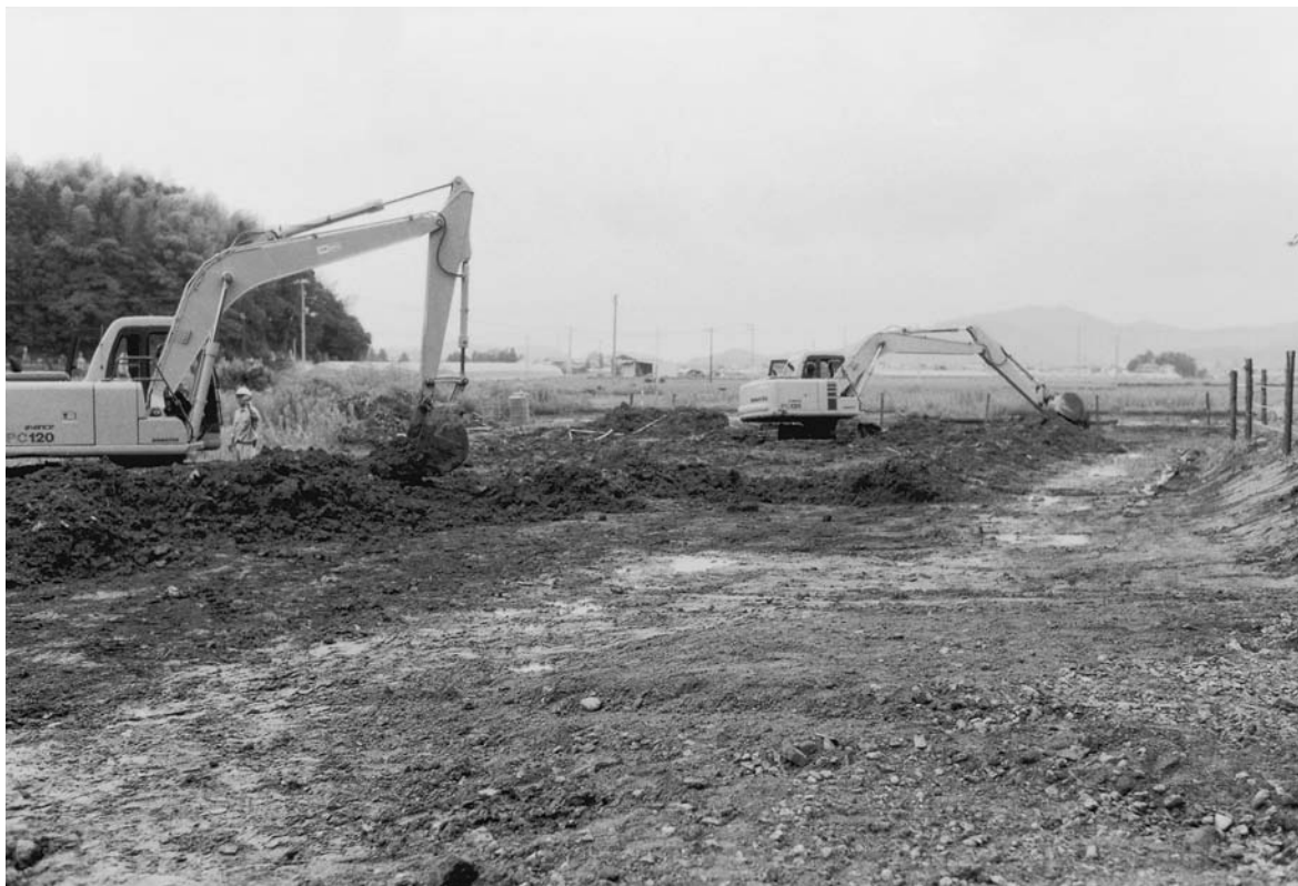
5 A区機械掘削状況
