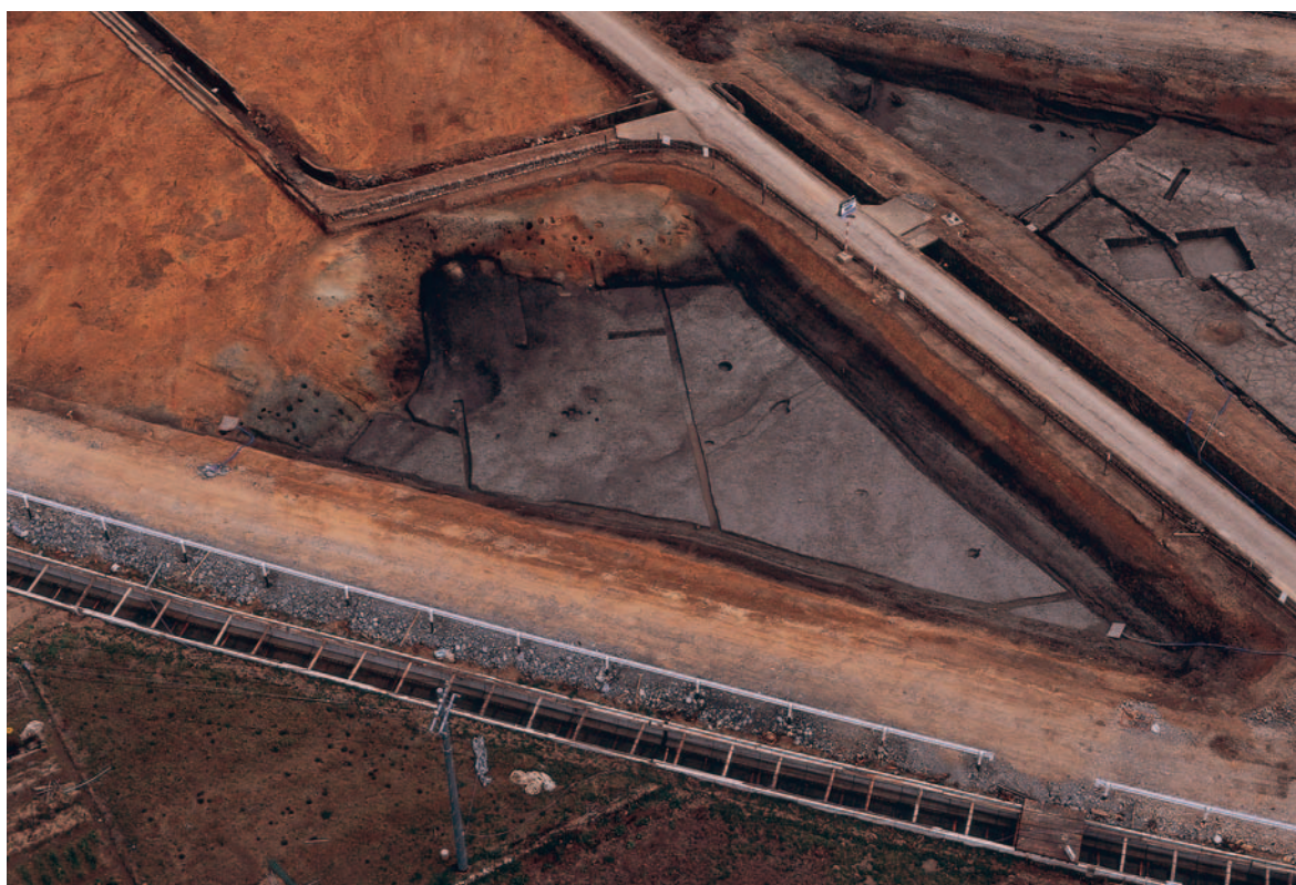
同上（北西より）
