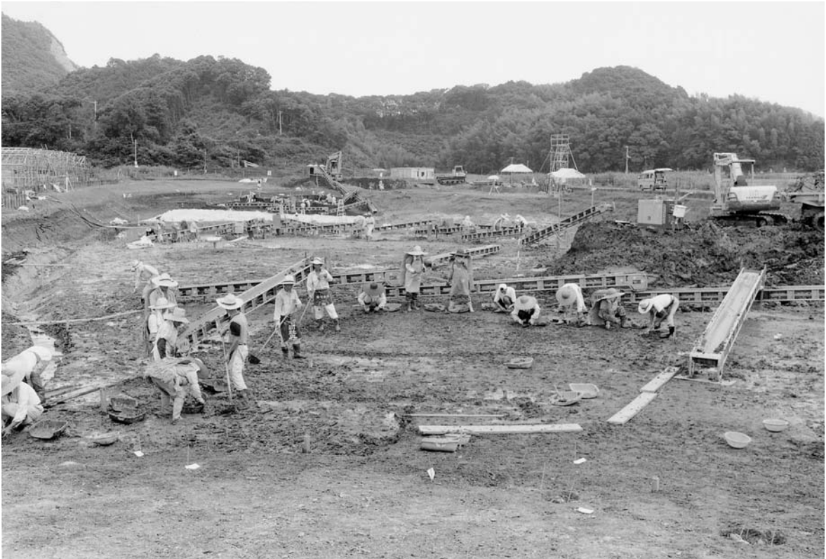
4 D区北西部調査状況
