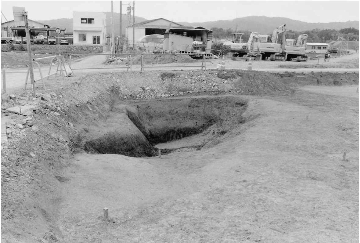
3A区SE区全景
