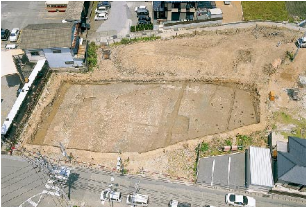
A区遺構完掘状態(南上空より)
