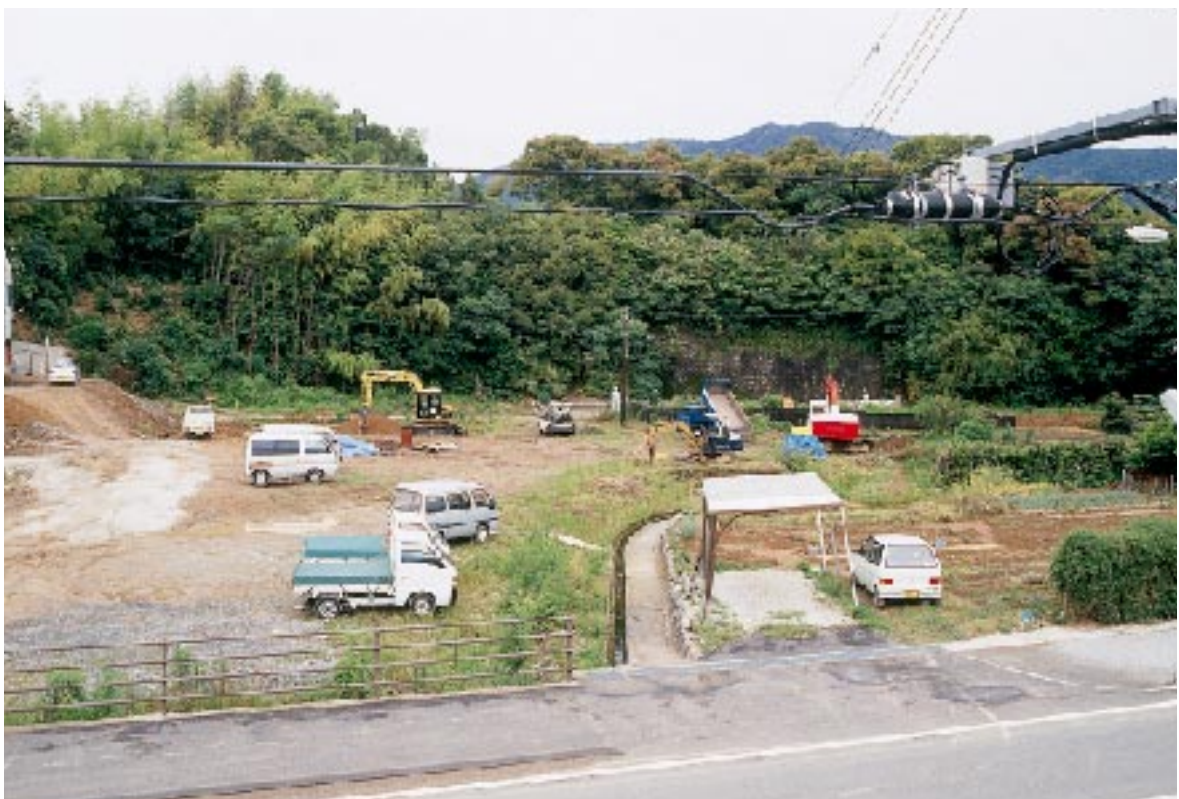
C区調査前全景(東より)
