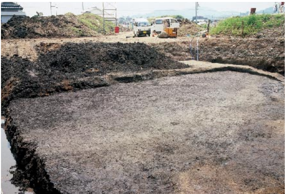
D区第Ⅱ・Ⅲ層完掘状態(北西より)
