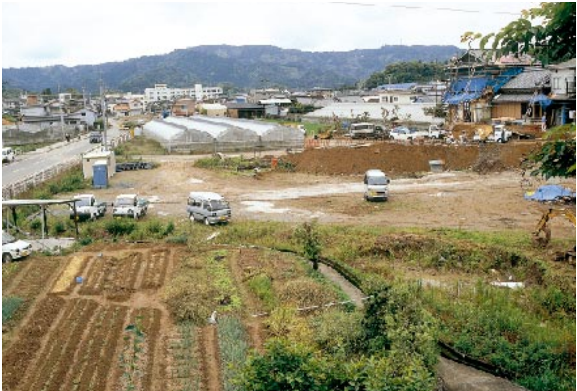
C区調査前全景(北より)
