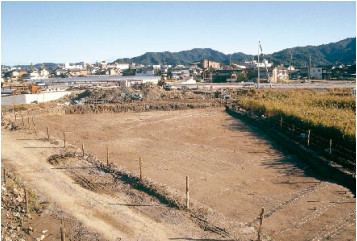
A区遺構検出状態(北西より)
