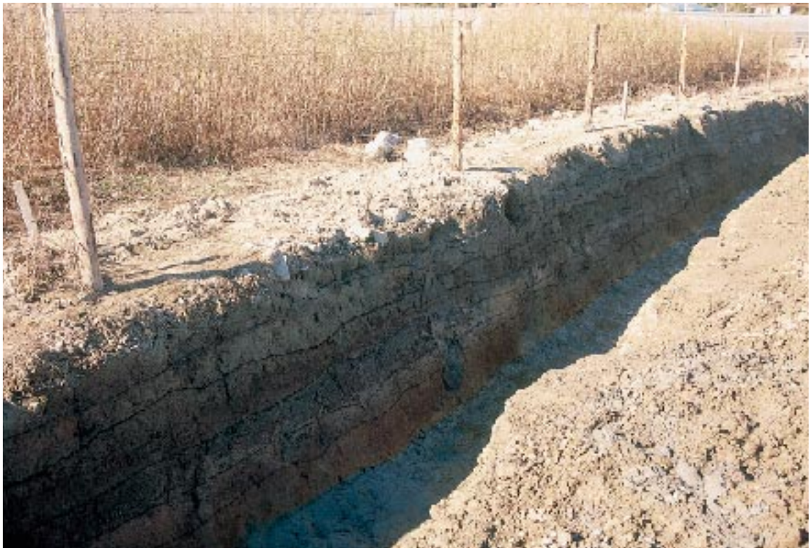
A区南壁セクション1 (北東より)
