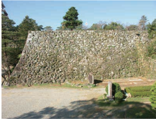
解体前の三ノ丸東面の石垣です。 ほとん 殆どがチャートですが、左上の角には砂岩が使われています。
