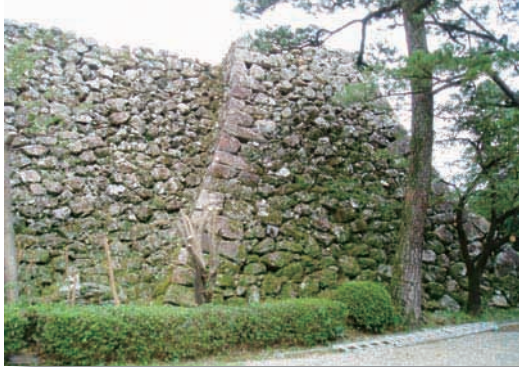
でずみ 出角(外に張り出した角)の様子
