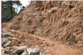
東側の地山掘削面
