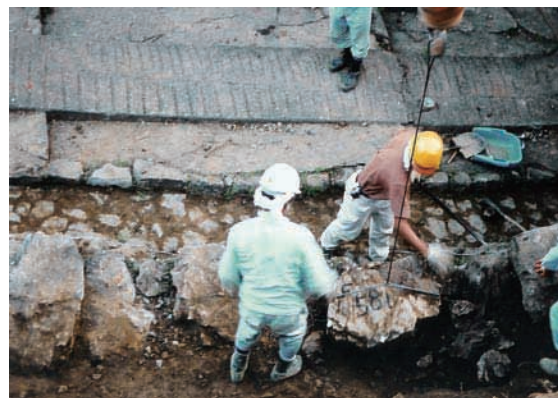
本丸南側石垣解体の様子②
