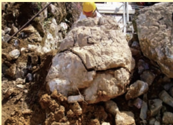
内部が割れている築石
