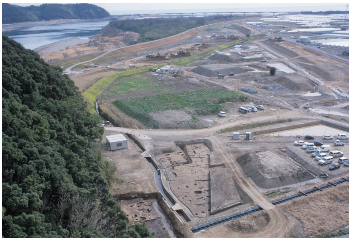
1 - 3 拡張区調査前風景 北西から 手前1 - 3A・B区
