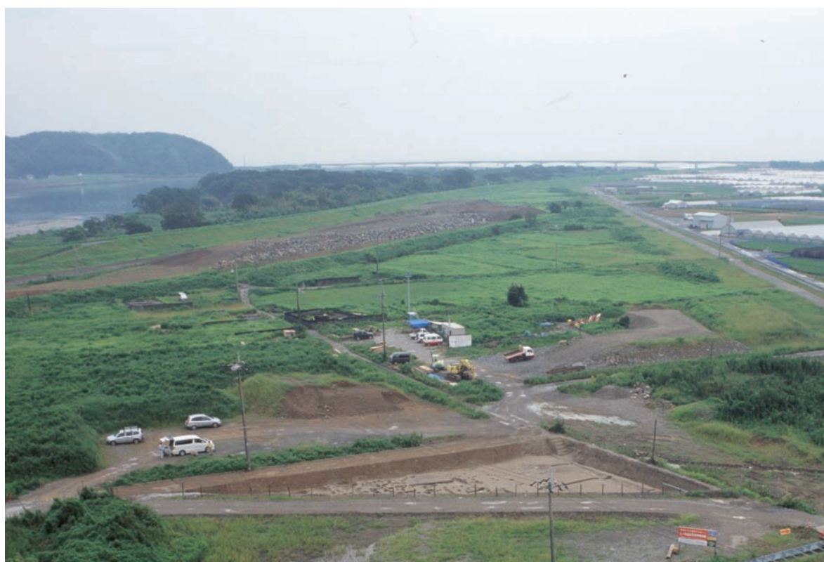
1 - 1 区調査区遠景 北西から
