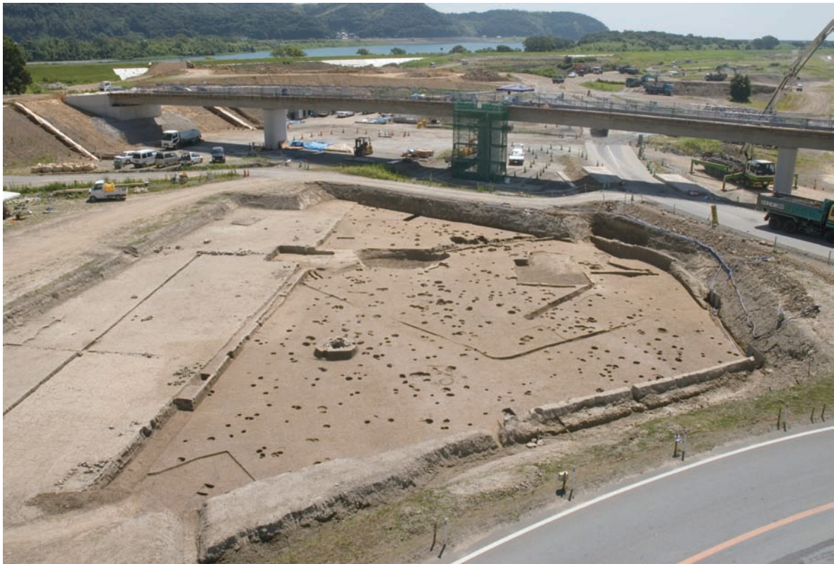
1 - 5区最下面完掘状況 西から
