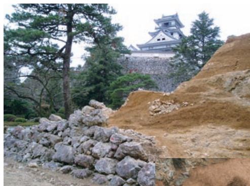
三ノ丸の石垣解体工事
