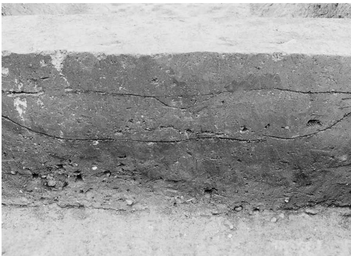
I区 SD3 セクション (南より)
