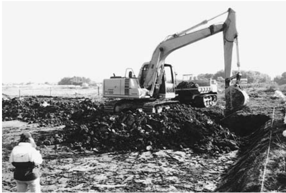
1D区機械掘削状況（北より）
