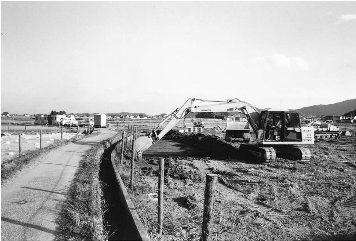
IC区調査状況・機械掘削（西より）
