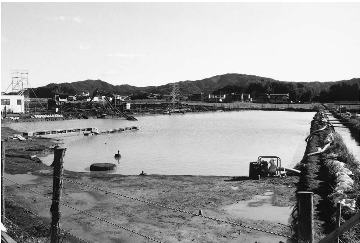
1C区冠水状況（北より）
