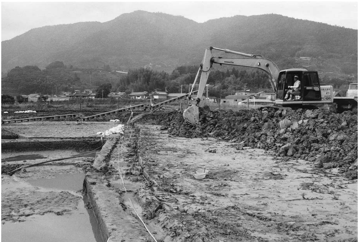
1B区機械掘削状況
