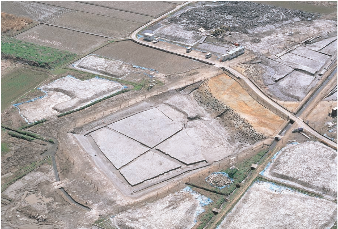
1A・1B区完掘状態（北西より）
