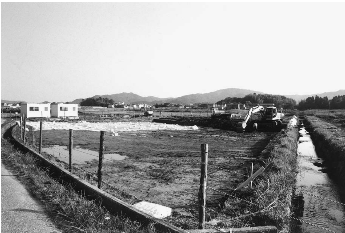
同 上（北西より）
