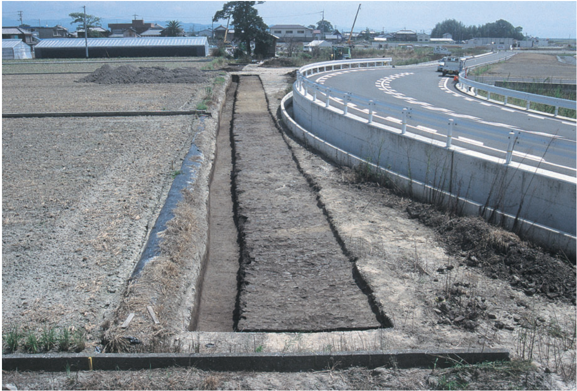
B区②Ⅱ 完掘状況（西より）
